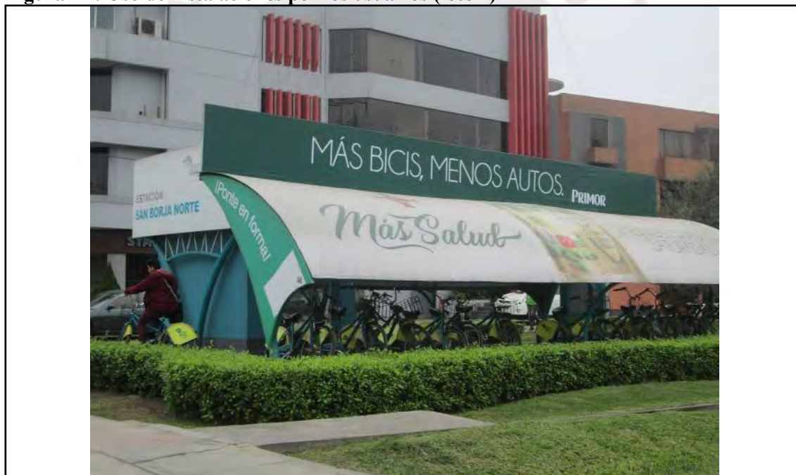
Figura T2: Uso de instalaciones por los usuarios (foto 7)
