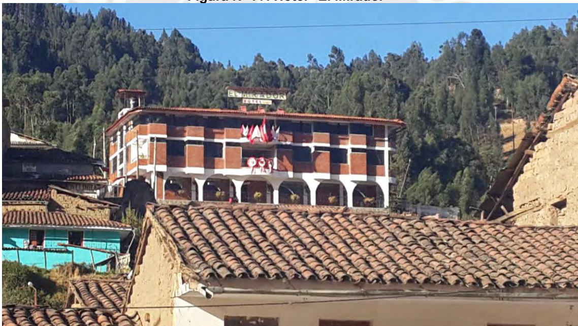
Figura N° 77. Hotel “El Mirador”
