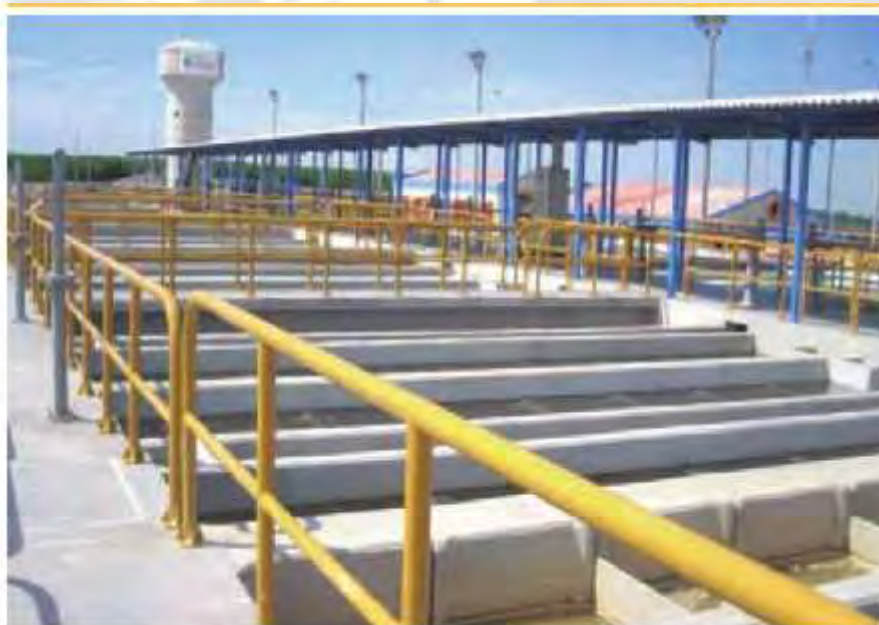
Figura 7. Planta de tratamiento de agua Curumuy.
