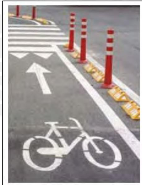
Figura 44. Ejemplo de hitos verticales de poliuretano, Bogotá
