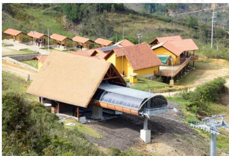
Figura 3.10 Construcción del Andén de Llegada. Fuente: MINCETUR
