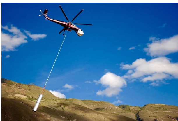
Figura 3.14 Traslado en helicóptero de pieza de torre de línea. Fuente: Sitio web de Telecabinas Kuélap.
