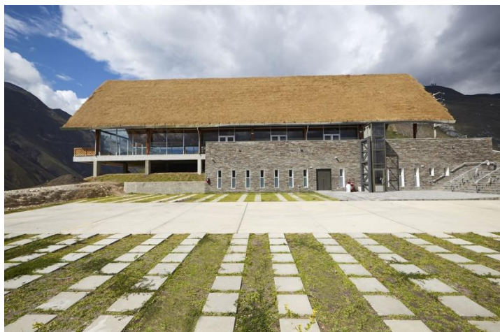
Figura 3.8 Vista de la Estación de Embarque
