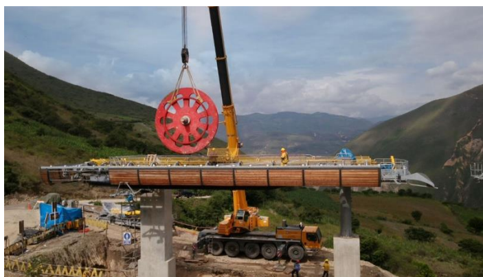
Figura 3.9 Construcción del Andén de Salida. Se muestra la colocación de la estación motriz del sistema de telecabinas.
