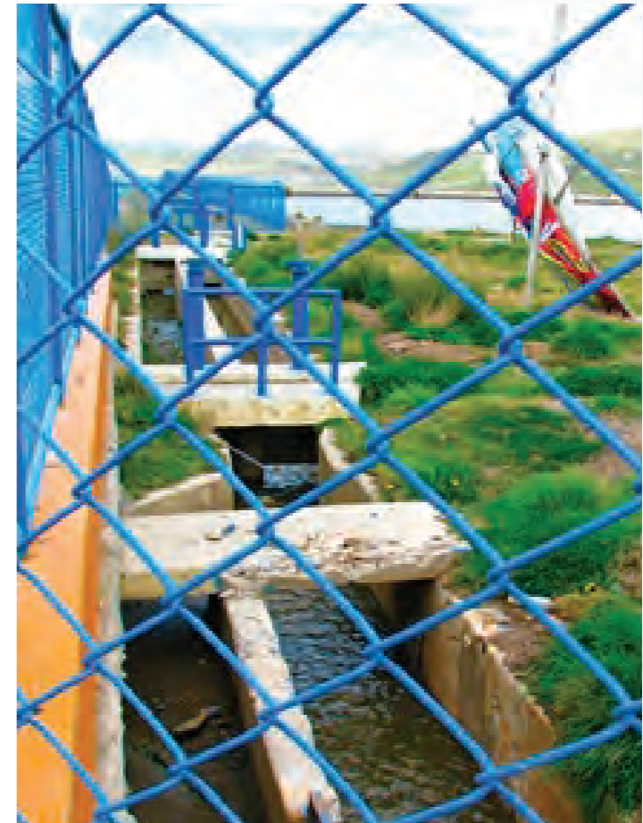
Foto 3. Punto de entrada contratamiento preliminar (reja con canal del bypass y desarenador)
