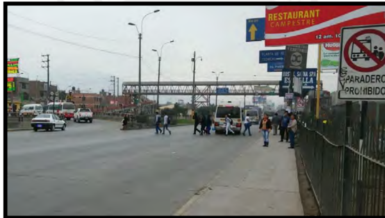
Figura 2.10 Puente peatonal sin uso ubicado en el cruce de la Av. Nicolás Ayllón y la Av. Nicolás de Pierola
