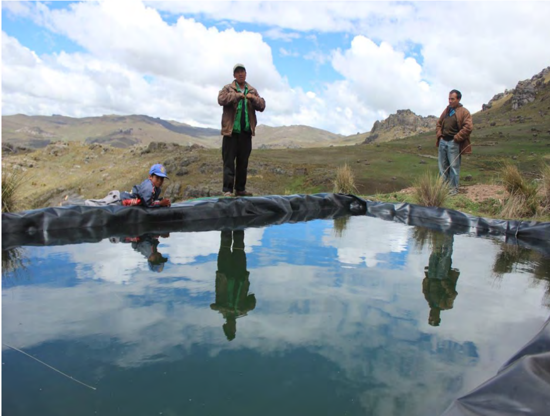
Fotografía 2. Tecnología micro-reservorio de agua
