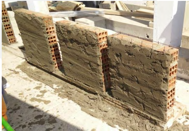
Figura N° 32: Tarrajeo de muretes tipo M3
