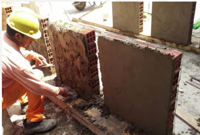
Figura N° 28: Tarrajeado y perfilado de murete tipo M2
