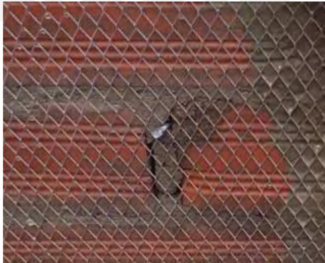
Figura N° 26: Fijación de malla para tarrajeo en murete tipo M2 con alcayatas
