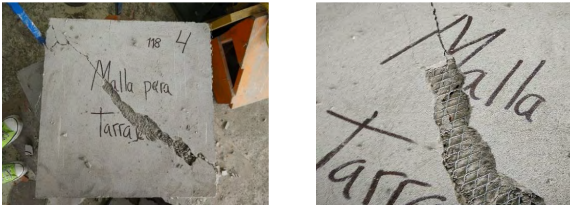
Figura N° 45: Autopsia de murete N° 4
