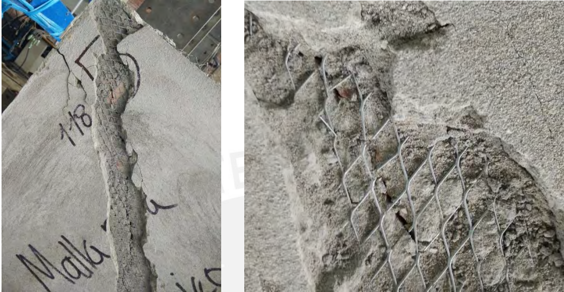
Figura N° 46: Autopsia de murete N° 5
