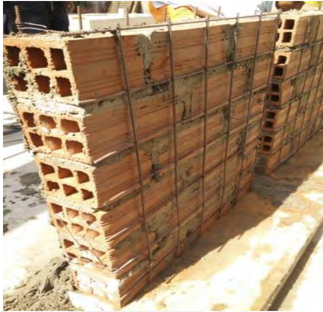
Figura N° 31: Fijación de malla electrosoldada a murete tipo M3
