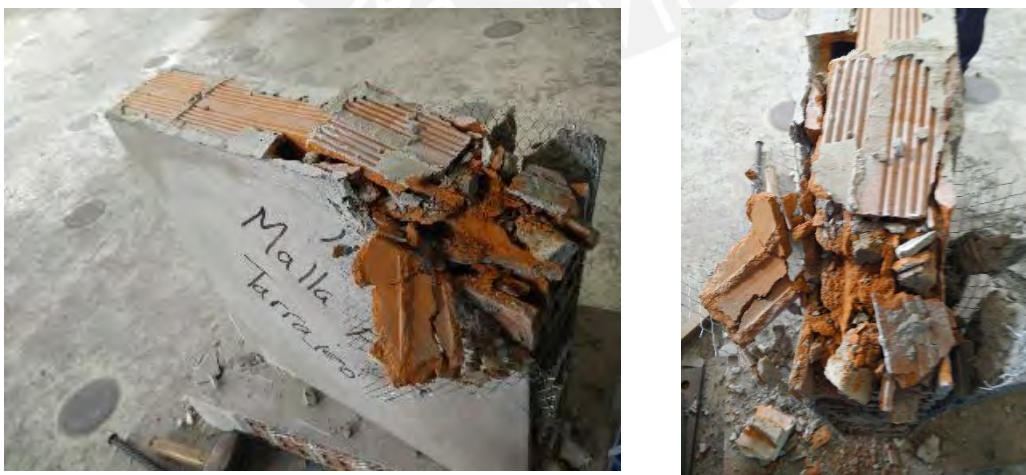
Figura N° 47: Autopsia de murete N° 6
