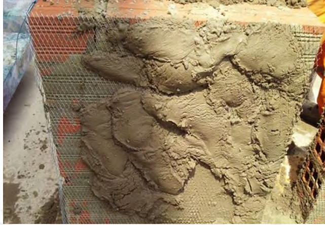
Figura N° 27: Tarrajeo de murete tipo M2
