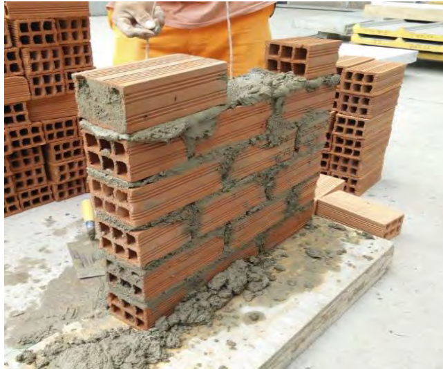
Figura N° 23: Relleno de alveolos tubulares con mortero
