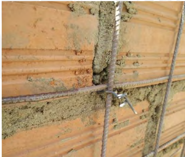
Figura N° 30: Atortolado de alambre con malla electrosoldada en murete tipo M3
