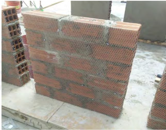
Figura N° 25: Fijación de malla para tarrajeo en murete tipo M2
