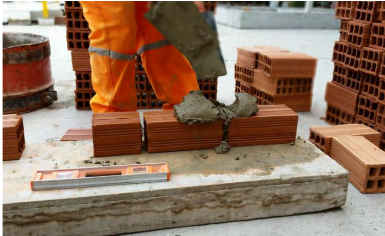
Figura N° 21: Asentado y relleno de mortero de primera hilada
