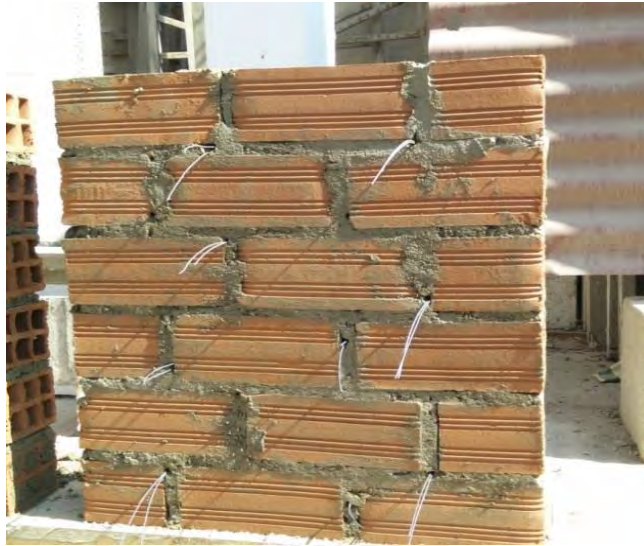
Figura N° 29: Colocación de alambres para sujetar murete tipo M3
