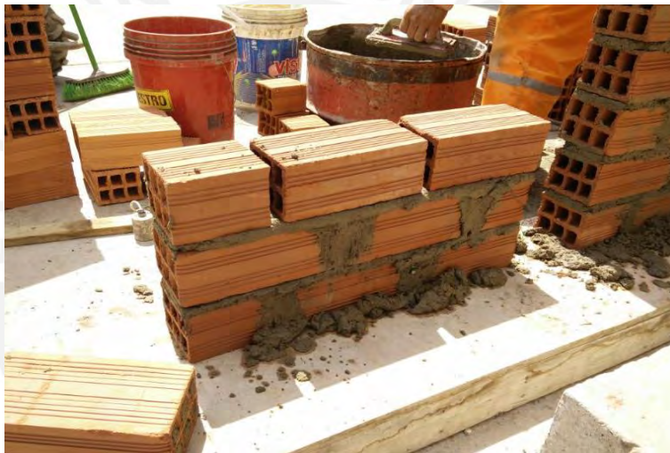
Figura N° 22: Asentado de ladrillos y mortero en murete Tipo M1
