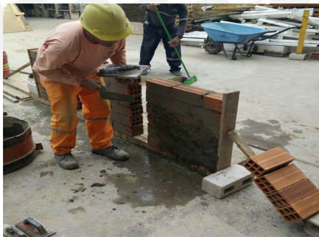
Figura N° 24: Tarrajado de murete tipo M1
