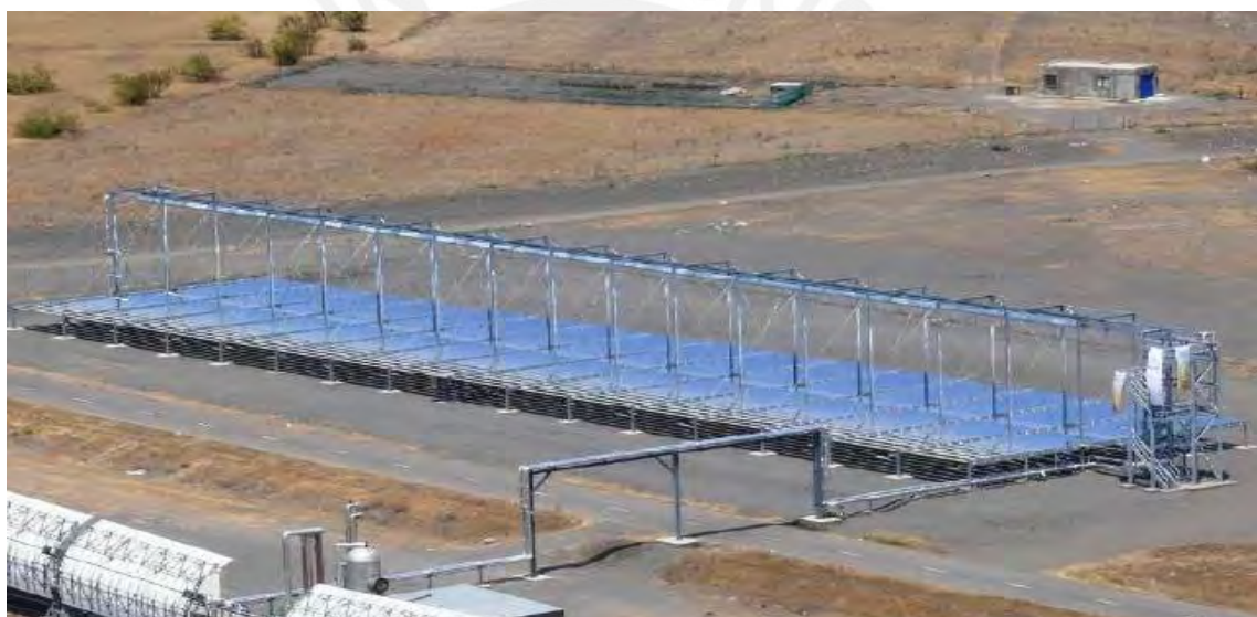
Figura I.6 - Vista de Planta LFC de prueba FresDemo/Ferrostaal - Almería, España (Fuente: SPG Ferrostaal, 2012).
