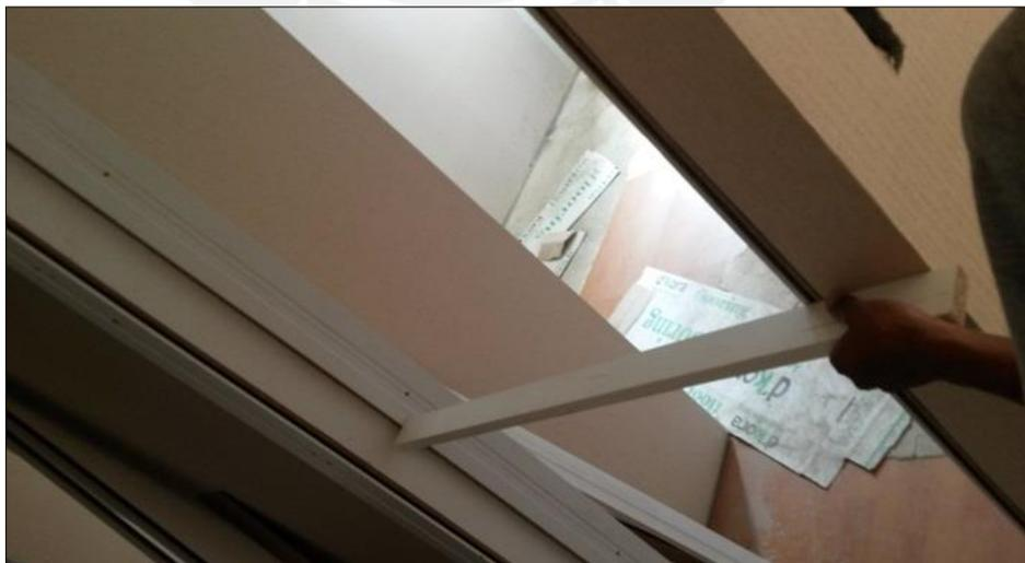
*Ilustración 10. Marco descuadrado de Puertas Prefabricadas (dep. 203). Fuente: Propia.*
