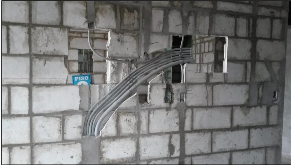
*Ilustración 4. Cambio de posición de tablero eléctrico. Fuente: Propia.*
