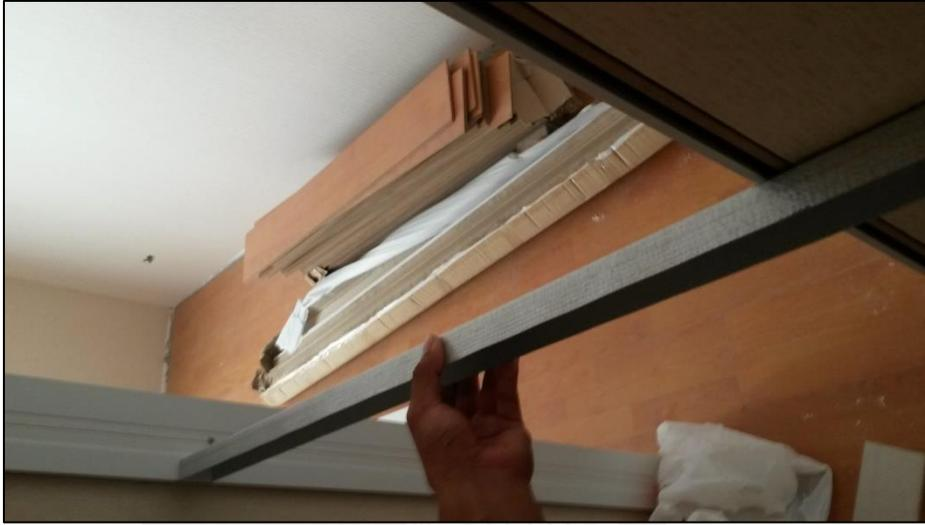
*Ilustración 9. Marco descuadrado de Puertas Prefabricadas (dep. 201). Fuente: Propia.*
