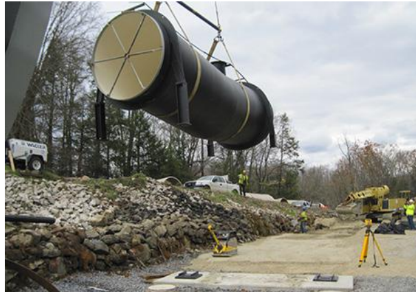
Figura 2-20 Barras rigidizadoras empleadas en el transporte de la tubería forzada Fuente: Anexo B, Figuras y fotografías
