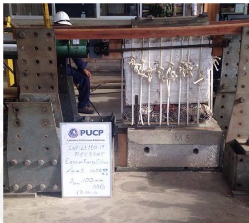
Figura 57 Ensayo de carga cíclica del muro M6
