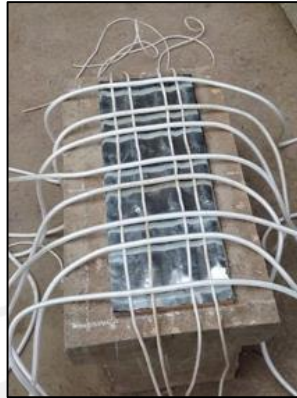
Figura 26 Colocación de drizas como líneas guía de la distribución de cubos de madera y canicas en el sobrecimiento
