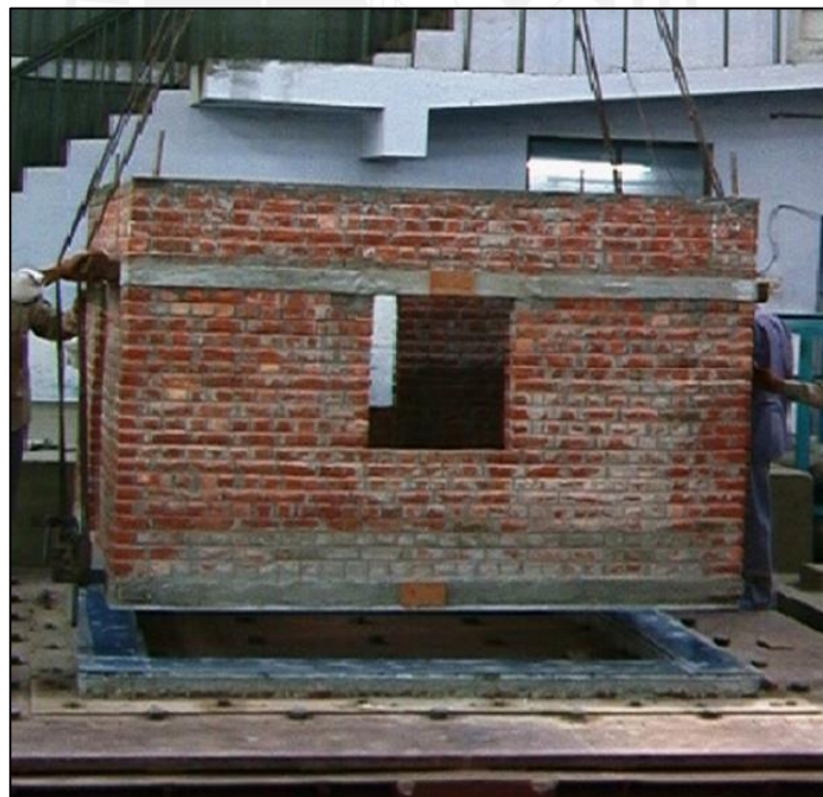
Figura 2 Alineamiento del módulo de albañilería con el simulador sísmico (cimiento) para el ensayo dinámico (Fuente: Radhikesh P. Nanda, et. al. 2016, 4)
