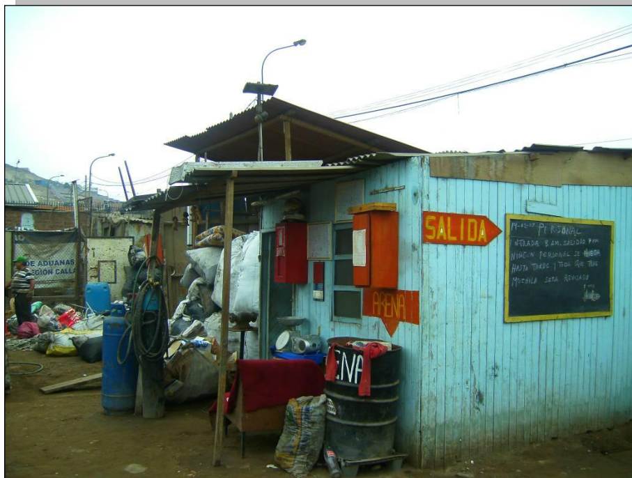
Empresa “Compra y venta de materiales de reciclaje”: Mínimas condiciones de seguridad en la empresa.
