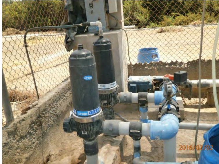
Figura 6.6 Filtro de anillos, Sector Los Olivos
