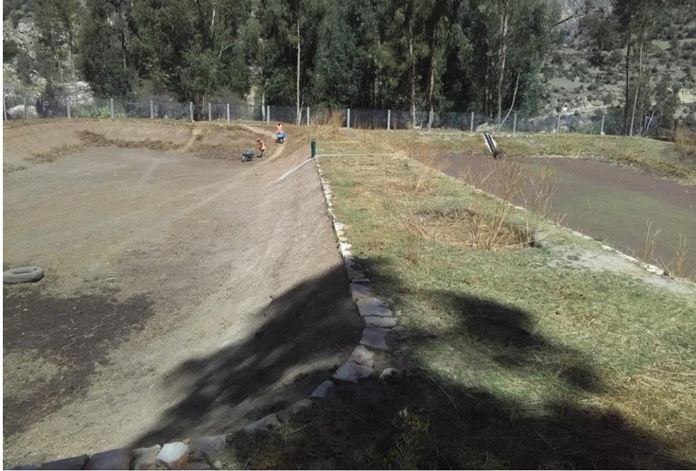
Figura 16. Poza de oxidación en reparación. Por Miguel Mendoza F, 14-10-2016.
