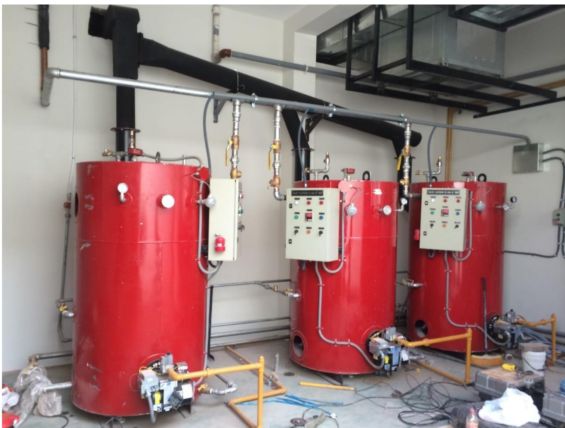
Figura 3.- Cuarto de bombas Hotel San Agustín Plaza
