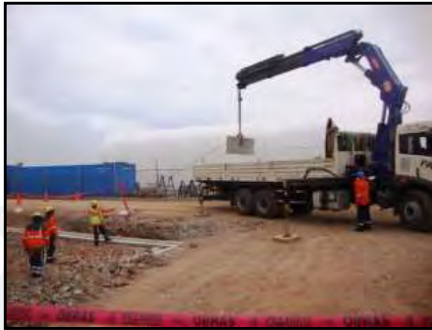
Imagen 28: Izaje de primer paramento
