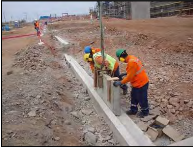
Imagen 29: Colocación de primer Paramento
