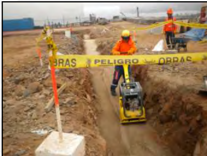
Imagen 24: Compactación para Solera de Nivelación
