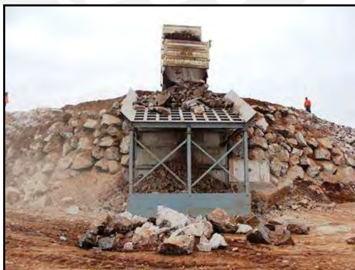
Imagen 18: Selección de material de Pedraplén mediante Zaranda
