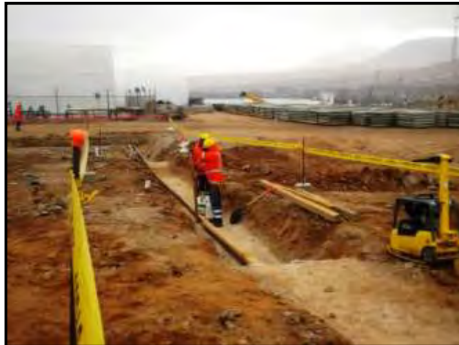
Imagen 25: Colocación del encofrado
