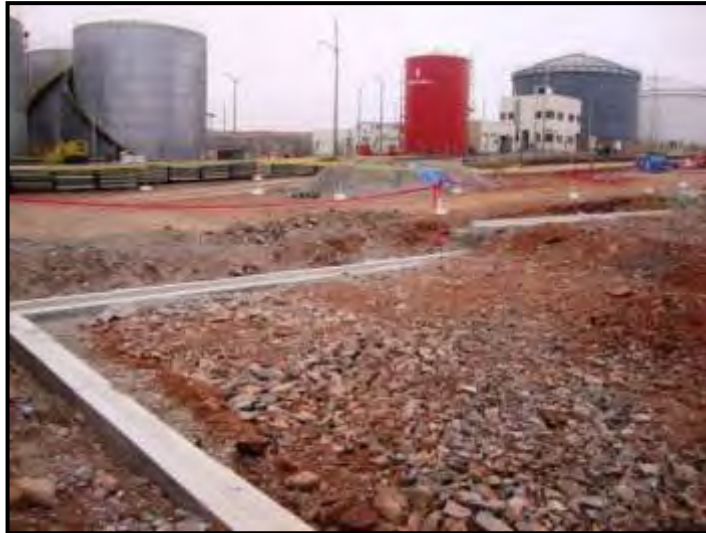
Imagen 27: Soleras terminadas
