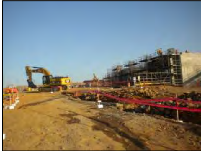
Imagen 23: Excavación de Solera de nivelación
