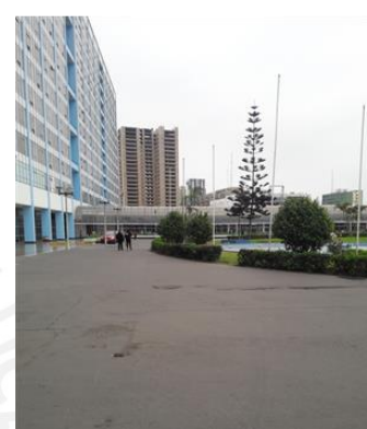
h) Techo de oficinas
