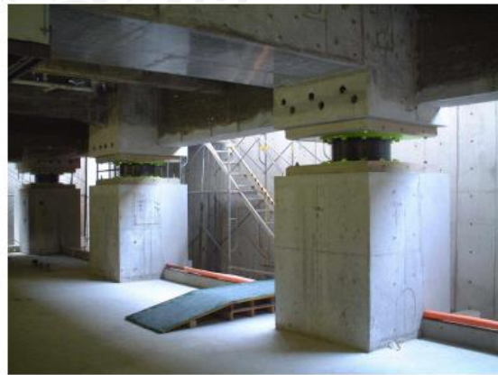
Reforzamiento con aislamiento completado
