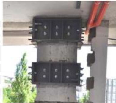
b) Colocación de soportes de acero
