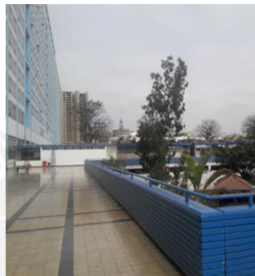
g) Techo de oficinas adyacente al bloque A
