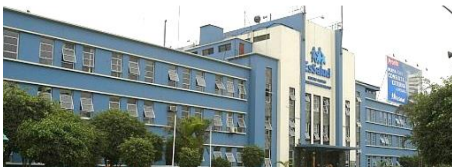
Figura 3-2 Hospital Nacional Guillermo Almenara (Fuente: http://infraestructuraperuana.blogspot.pe/ )
