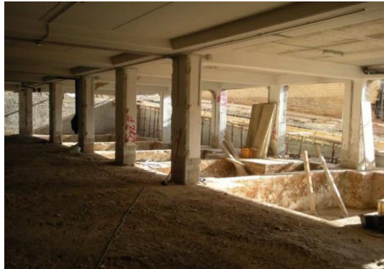
Figura 6-12 Elementos no estructurales retirados (Luca'Trombetta, Castellano, & Cocchio, 2014)
