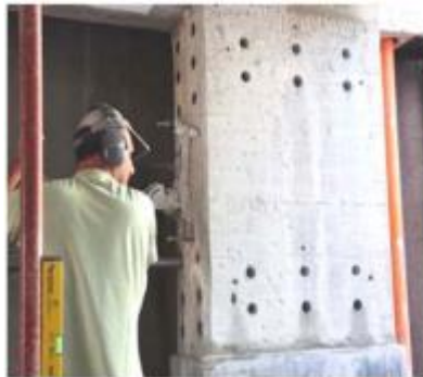
a) Perforación de la columna
