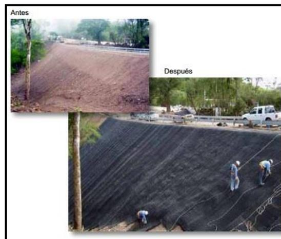
**Fig. 12** Colocación de biomantas para control de erosión en carreteras
