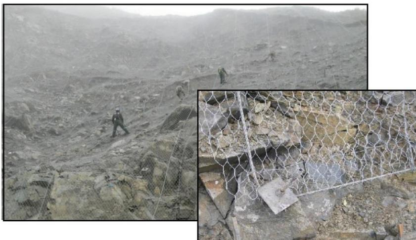
**Fig. 10 Control de derrumbes mediante pernos autoperforantes y mallas de acero**
