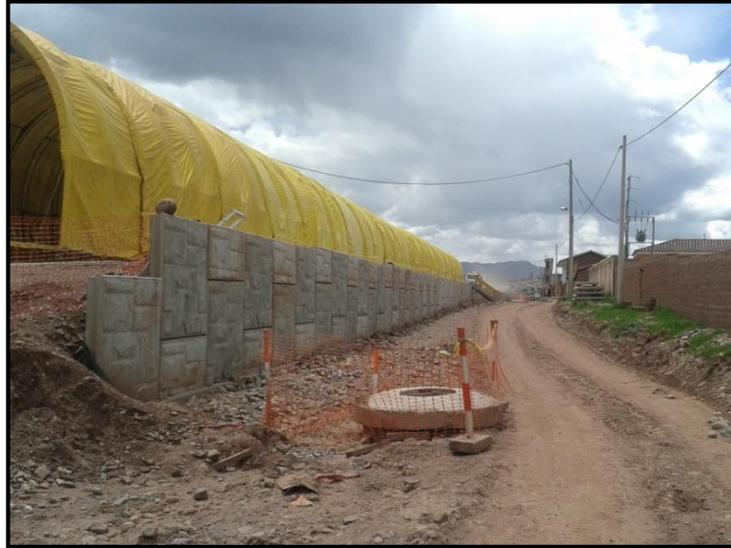
**Fig. 11** Uso de tenso estructuras como protección de lluvias en obras viales.
