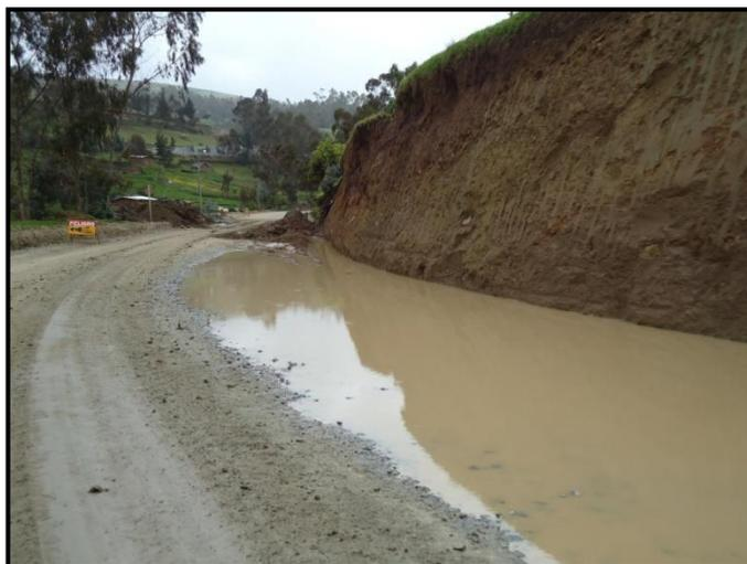
**Fig. 8 Empozamiento de agua a causa de precipitaciones en la zona**
