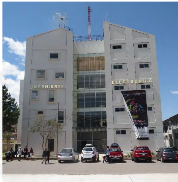
Figura 3.11: Edificio universitario de Electrónica de la UNSAAC.
