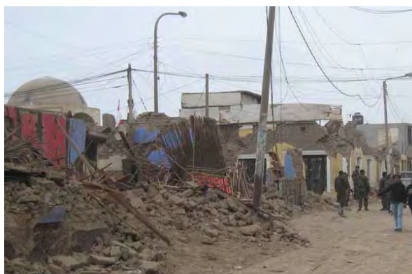
Figura 1.2 Viviendas de adobe destruidas durante el terremoto de Pisco, Perú (Blondet, 2007)
