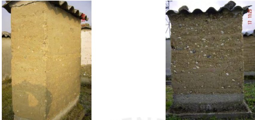
(a) Muro estabilizado con cal hidráulica (b) Muro sin estabilizar
