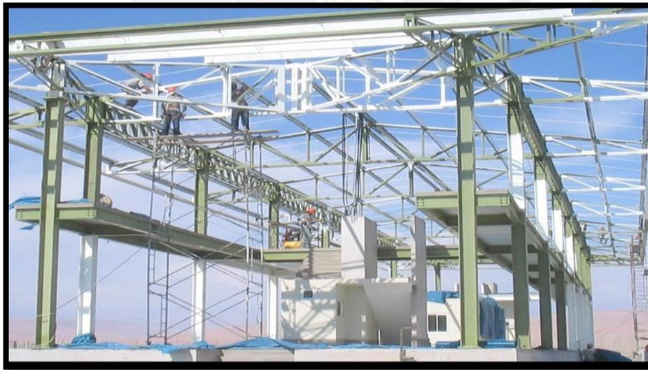
*Figura 19: Estructura montada en su totalidad e iniciando pintura (fuente propia)*
