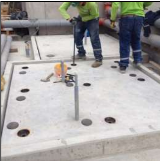
Fotografía 49: Procedimiento de ajuste de dispositivos para losas flotantes (Cuarto de Servidores)
