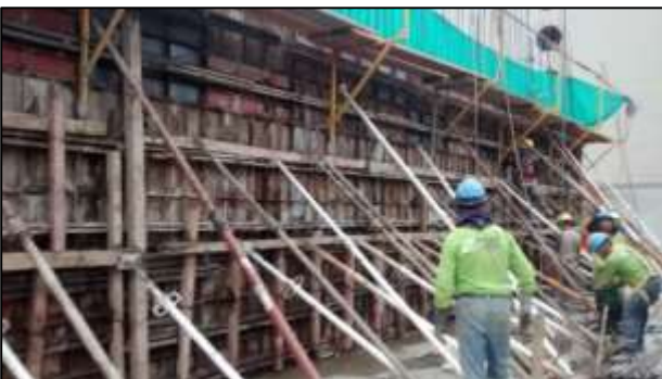
Fotografía 68: Placa P-3 ubicada en los ejes A (1/8).
