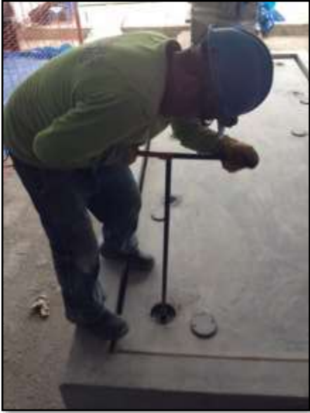
Fotografía 34: Se procedió 6 giros en sentido horario en cada dispositivo y luego 2 giros en el mismo sentido continuando una secuencia hasta nivelar la losa flotante.
