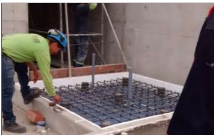
Fotografía 44: Armado de aisladores y malla de acero del sistema de bombeo condensado secundario (Cuarto de Servidores).
