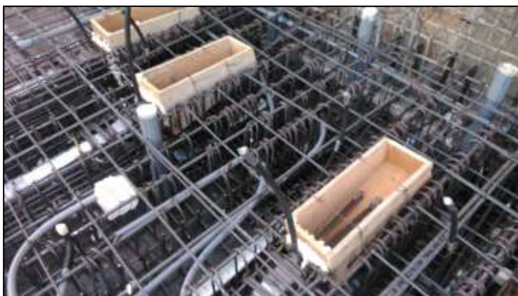
Fotografía 56: Es importante realizar una inspección ocular de la colocación de los anclajes en las cajuelas, se aprecian los tendones que salen del anclaje, los mismos que serán tensados luego del vaciado.
