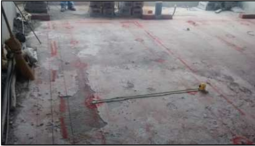
Fotografía 15: Verificación de ubicación de aislantes para losa flotante de EQUIPOS CHILLERS 01 y 02.
