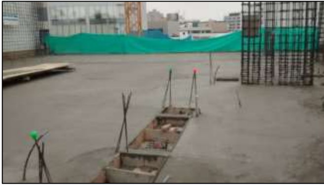
Fotografía 70: Vaciado de losa piso 03 – sector 02.
