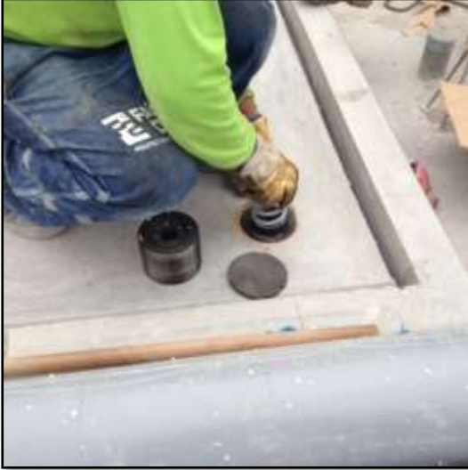
Fotografía 48: Colocación de resortes con la base de neopreno en el interior del mouting.
