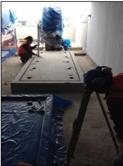
Fotografía 36: Como último procedimiento se niveló la topografía de la losa flotante (CHILLER 02).
