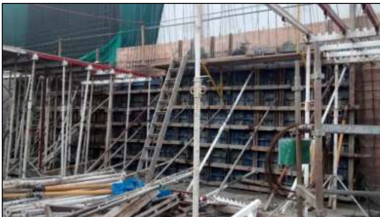
Fotografía 75: Placa P-1 ubicada en los ejes H / (6,9), este elemento vertical corresponde al siguiente nivel (piso 04).
