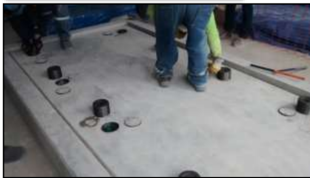
Fotografía 32: Cerrado de la tapa de Cover Plate con los resorts ya colocados.
