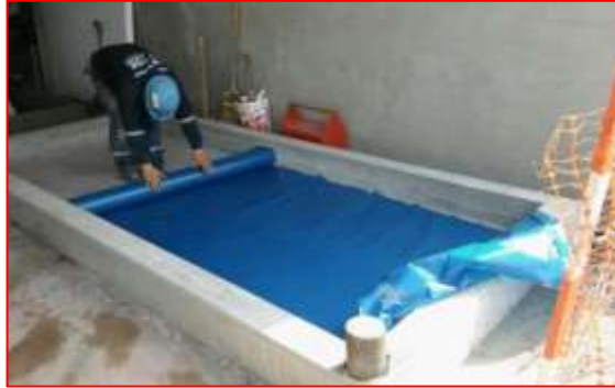
Fotografía 02: Colocación de polietileno Fuente: FASE DOS SAC
