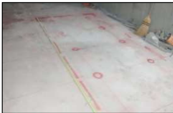
Fotografía 01: Trazo y replanteo Fuente: FASE DOS SAC
