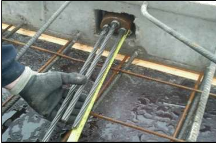
Fotografía 61: Verificación de elongaciones finales de tendones, posterior al tensado.
