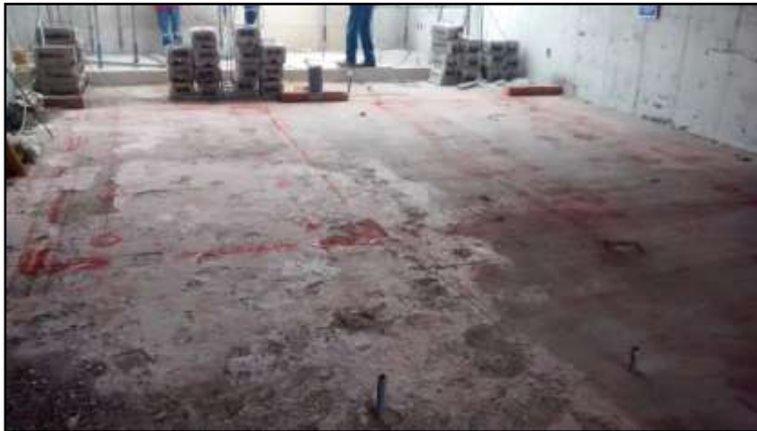
Fotografía 13: Limpieza y trazo para ubicación de EQUIPOS CHILLERS 01 y 02, según plano.
