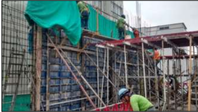
Fotografía 73: Placa P-2 ubicada en los ejes E / (8,12)
