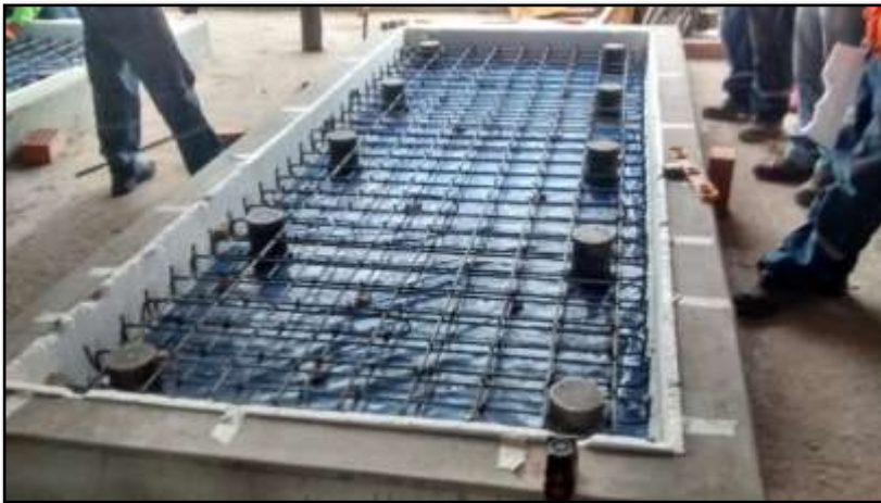
Fotografía 20: Armado de aisladores y malla de acero para equipo de CHILLER 02
