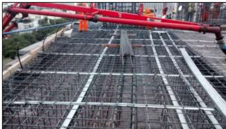
Fotografía 57: Se aprecia distribución de ductos metálicos con los tendones en su interior, en todo el largo de la viga.
