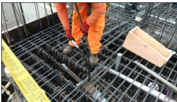
Fotografía 54: En el borde vivo, se instala una combinación de anclaje y formador de cajuela (casetón) de 10cm (4") de largo, que van asegurados al encofrado.
