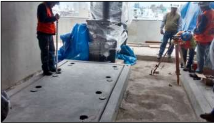
Fotografía 35: Como último procedimiento se niveló con ayuda de los equipos topográficos, la losa flotante (CHILLER 01).
