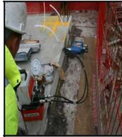
Fotografía 60: Colocación de gata hidráulica.
