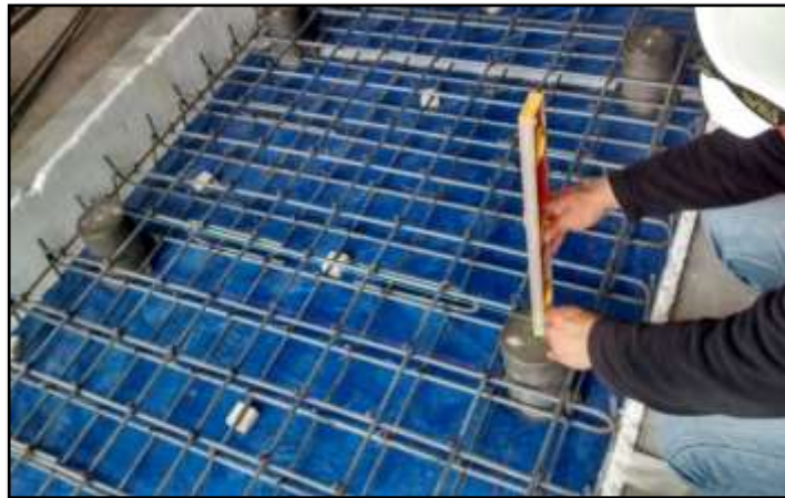
Fotografía 03: Colocación de moutings Fuente: FASE DOS SAC
