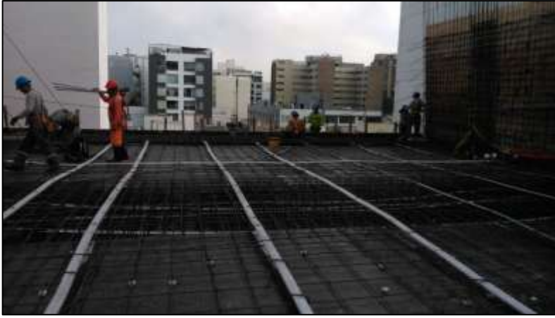
Fotografía 65 y 66: Verificación de medidas de catenarias de losa postensada
