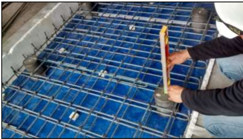
Fotografía 18: Nivelación de aisladores para recibir vaciado de concreto para equipo de CHILLER 01
