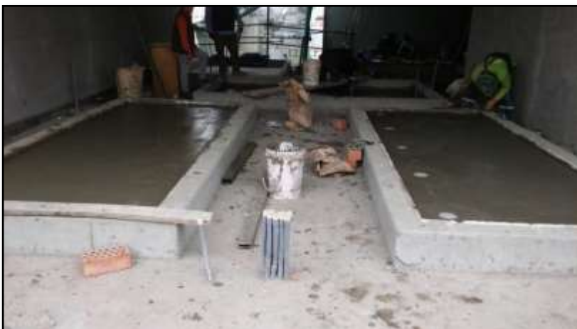
Fotografía 22: Vaciado de losas de concreto para equipos de CHILLERS 01 y 02
