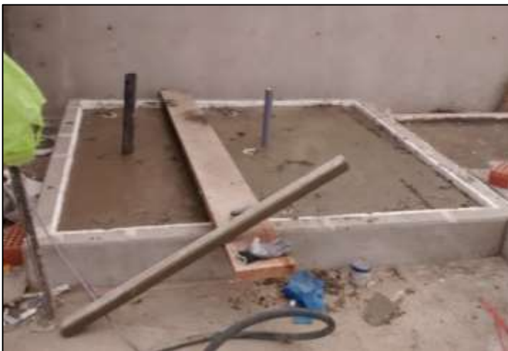
Fotografía 47: Vaciado de la losa flotante del sistema de bombeo condensado Secundario (Cuarto de Servidores).
