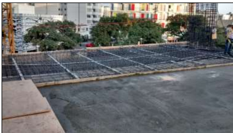
Fotografía 58: Se aprecia vaciado del 2do sector de losa, dejando una luz de dos tercios hacia la viga de fachada que será vaciada posteriormente.
