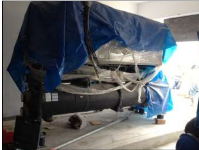
Fotografía 12: Montaje de equipos sobre losa flotante nivelada Fuente: FASE DOS SAC
