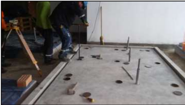
Fotografía 37 y 38: Nivelación de losa para el sistema de bombeo Primario.
