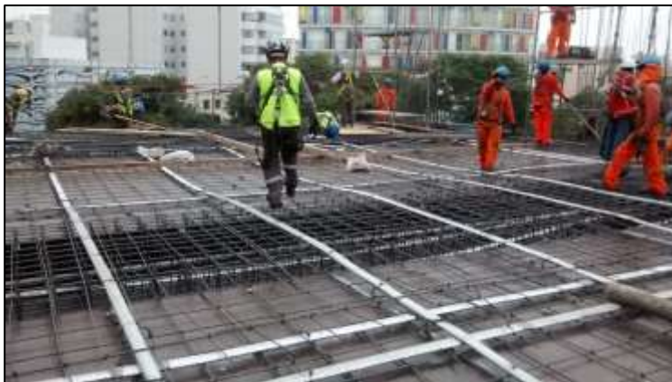
Fotografía 53: Encofrado de fondo de losa y bordes terminados, distribución de los ductos metálicos para dar inicio a la colocación de los tendones en el interior de los ductos.
