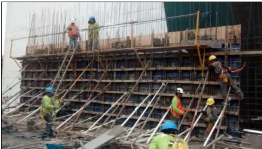
Fotografía 71: Vaciado de placa P-1 perteneciente al sector 01 – piso 04.
