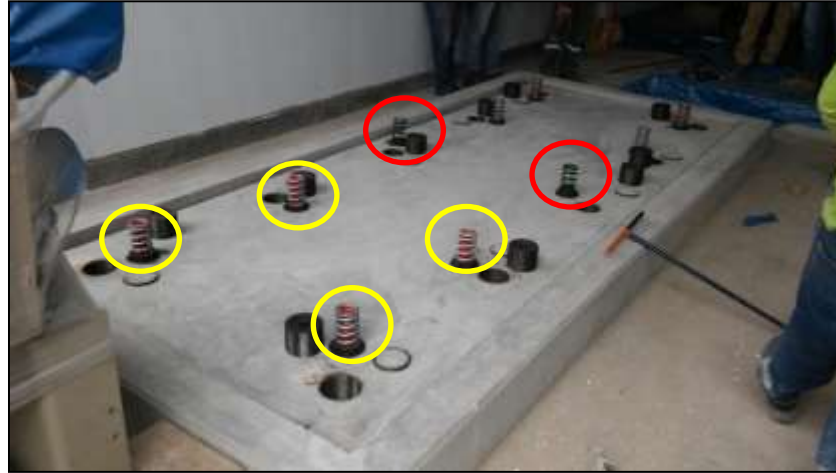
Fotografía 09: Montaje de resortes sobre la base de neopreno Fuente: FASE DOS SAC
