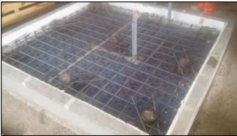
Fotografía 23: Armado de acero para el sistema de BOMBEO SECUNDARIO con los dispositivos de aislamiento
