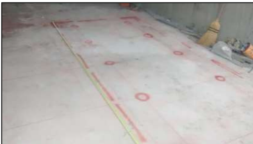
Fotografía 14: Liberación de medidas para sardinel de EQUIPOS CHILLERS 01 y 02.
