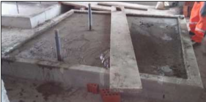
Fotografía 24: Vaciado de losa de concreto para el sistema de BOMBEO SECUNDARIO
