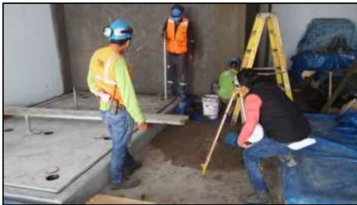
Fotografía 42: Nivelación de la losa flotante del sistema de bombeo Primario.
