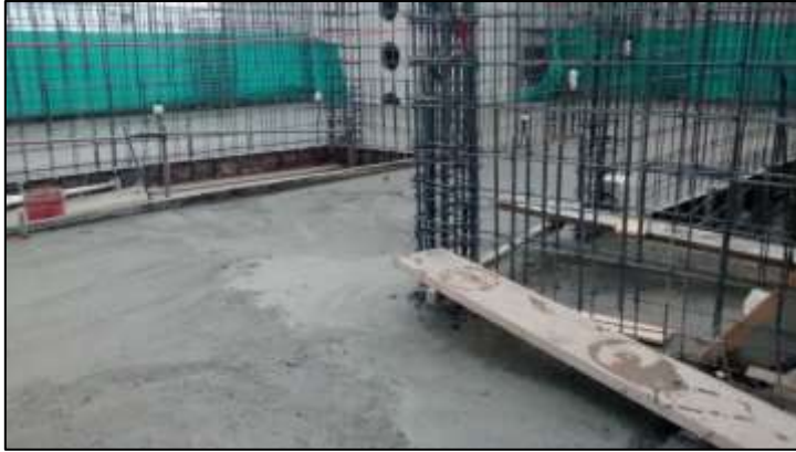
Fotografía 74: Vaciado de losa piso 03 – sector 03.
