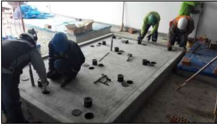
Fotografía 37 y 38: Nivelación de losa para el sistema de bombeo Primario.
