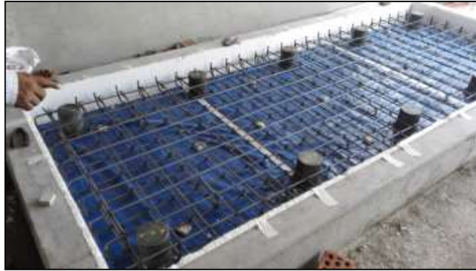
Fotografía 04: Nivelación de moutings Fuente: FASE DOS SAC
