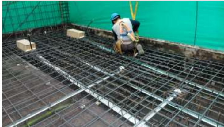
Fotografía 55: Se aprecia distribución de tendones con la cobertura de la ductería metálica en una viga típica del área a vaciar.
