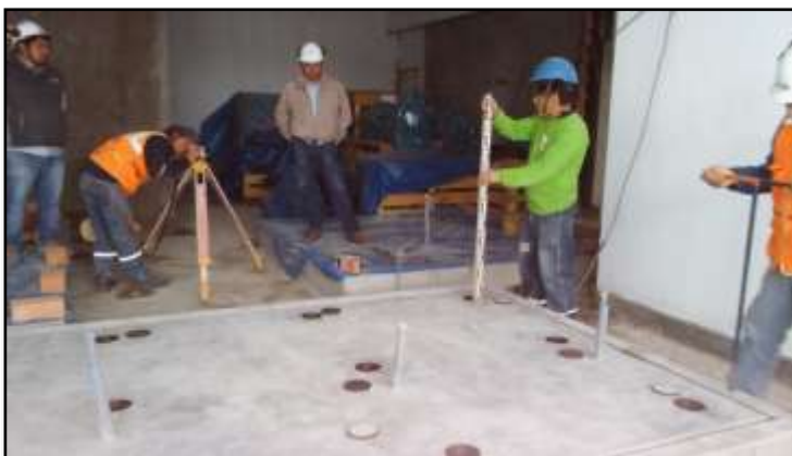
Fotografía 40: Nivelación de la losa flotante del sistema de bombeo Primario.
