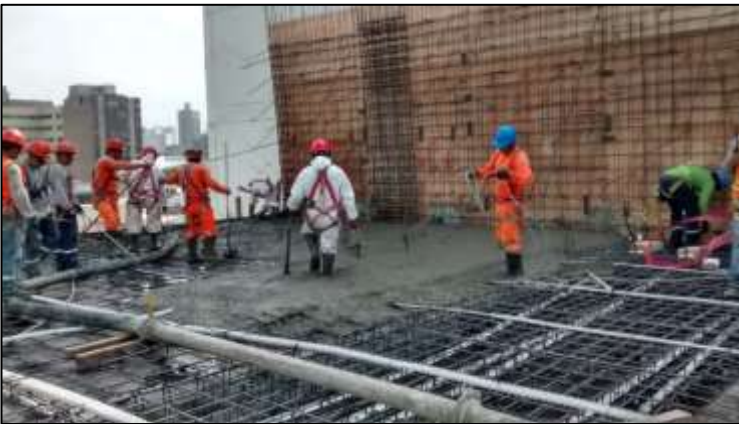
Fotografía 67: Vaciado de losa piso 03 – sector 01
