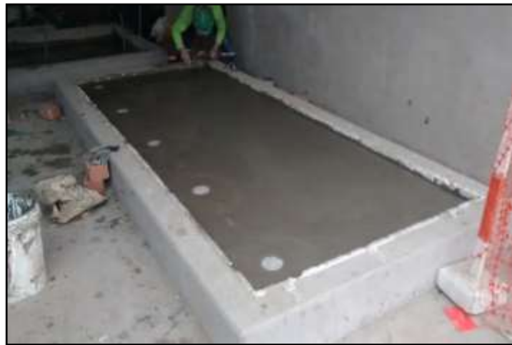
Fotografía 05: Vaciado de concreto en losa flotante Fuente: FASE DOS SAC
