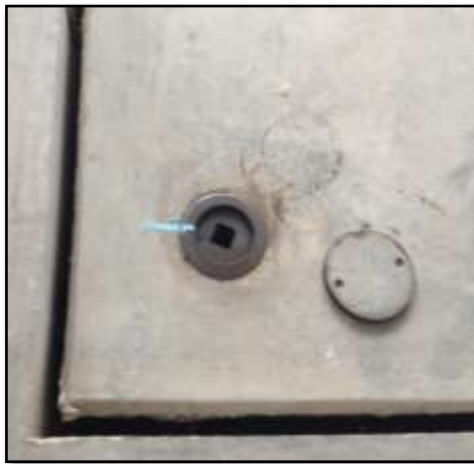
Fotografía 10 y 11: Giros en casting para elevación de losa Fuente: FASE DOS SAC
