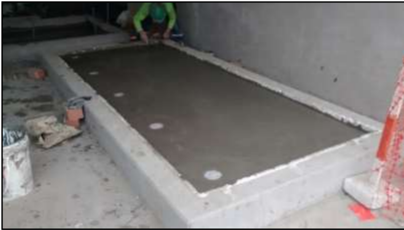
Fotografía 19: Vaciado de losa para equipo de CHILLER 01
