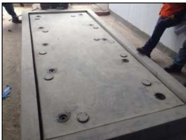
Fotografía 33: Colocación de marcas en Cover Plate para giros de acuerdo al procedimiento de nivelación de losa flotante.
