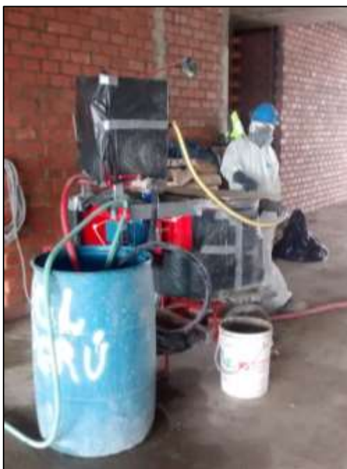
Fotografía 64: La Lechada agua/cemento, deberá alcanzar la resistencia de 280 Kg/cm 2 a los 28 días luego de haber sido inyectada la Losa y/o Viga.
