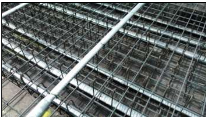
Fotografía 51: Se aprecian los ductos tendidos sobre losa armada, según configuración en plano.
