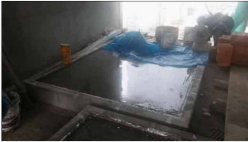
Fotografía 26: Vaciado de losa de concreto para el sistema de BOMBEO CONDENSADO
