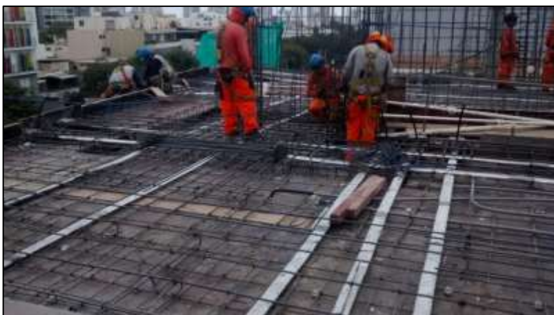
Fotografía 72: Armado de losa y viga pos-tensada piso 03 – sector 03.
