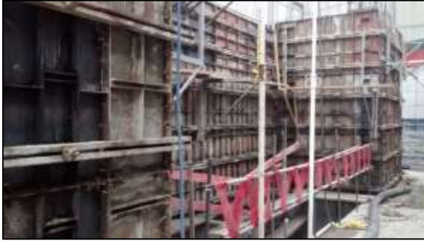
Fotografía 69: Placa de ascensor ubicada en los ejes (3,7) / (B, B').
