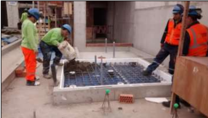
Fotografía 46: Vaciado de la losa flotante del sistema de bombeo condensado Primario (Cuarto de Servidores).
