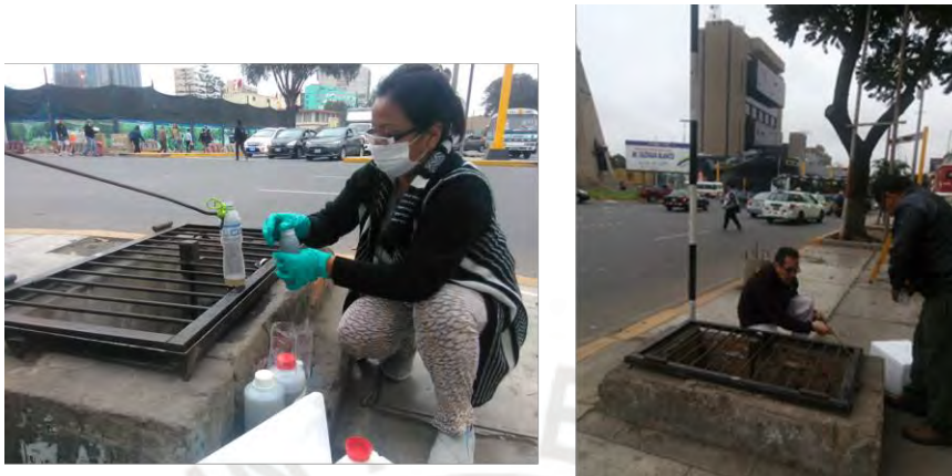
Figura 8. Punto 1: Buzón de paso del canal Huatica, entre las avenidas 28 de Julio y Washington. Para obtener la muestra se usó una botella de plástico de agua para beber que pudiera caber por la rendija de la tapa del buzón (Fecha: 07 de agosto de 2017. Fuente: propia)
