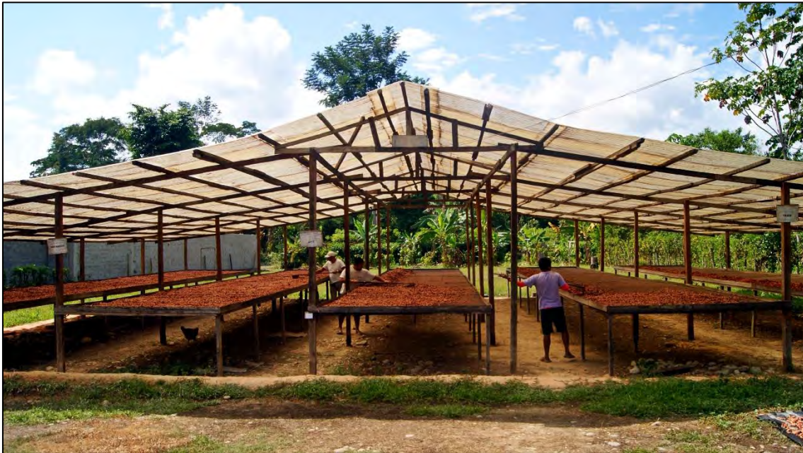
Figura N10: Instalaciones de secado-sede Tocache
