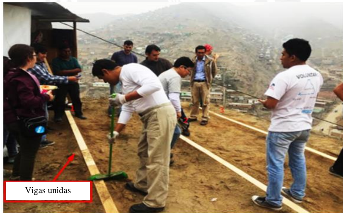
Figura 13: Colocación de vigas por parte de los voluntarios de TECHO
