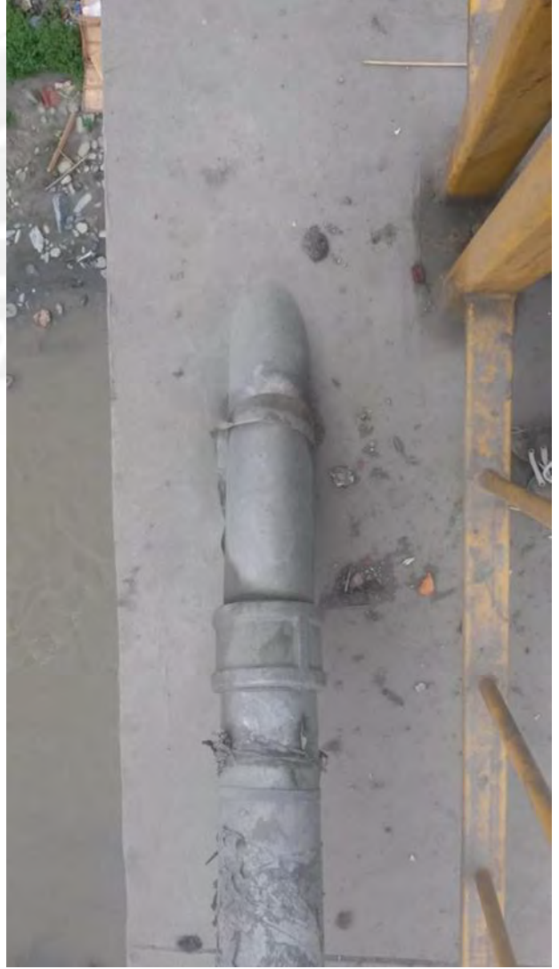
Foto 29 - Ingreso al puente por el distrito del Agustino
