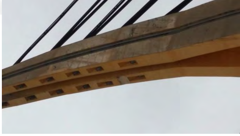
Foto 66 – Detalle del anclaje de los cables en la torre
