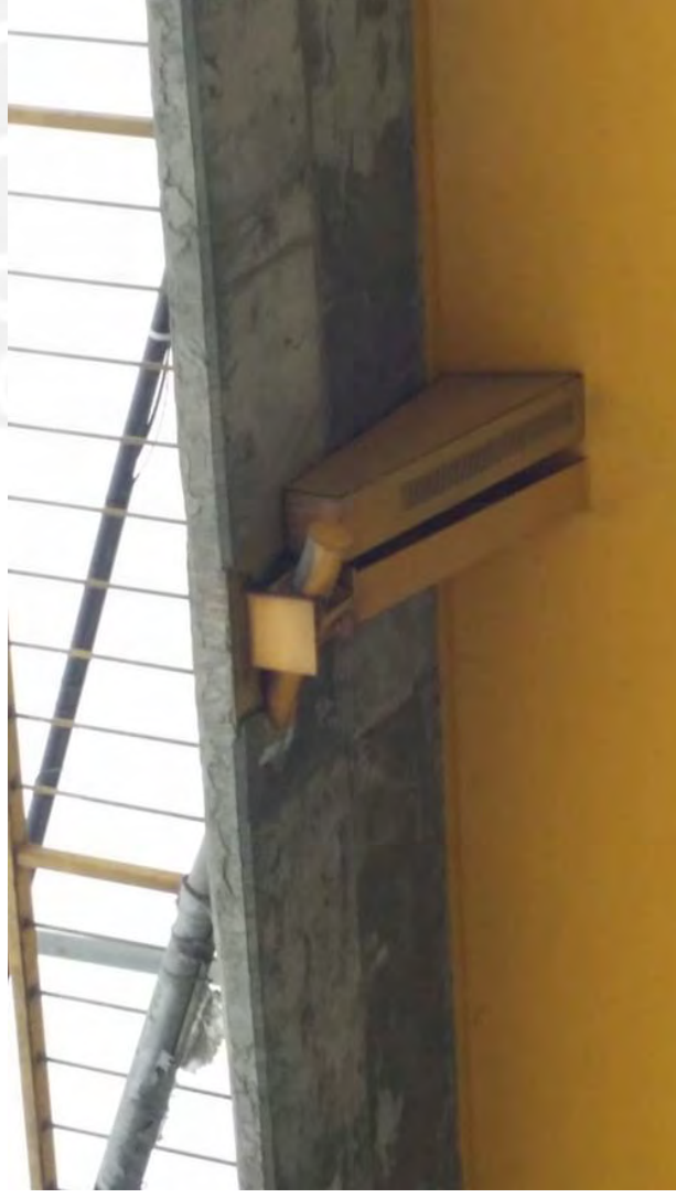
Foto 68 – Detalle del anclaje de los cables en la viga diafragma
