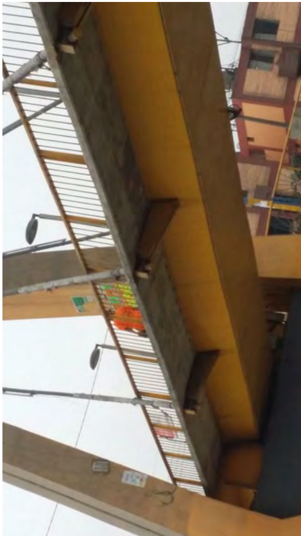
Foto 26 – Vista de las vigas diafragma a lo largo de la viga metálica
