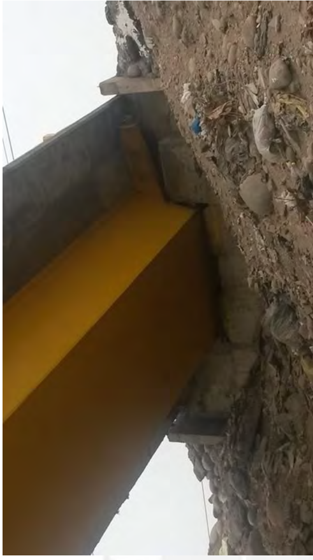
Foto 22 – Vista de la cajuela del estribo izquierdo
