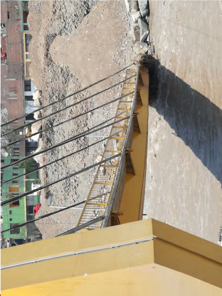
Foto 46 – Vista del suelo malo donde fue cimentado el estribo izquierdo
