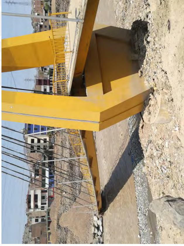
Foto 34 – Tramo de la viga de concreto armado
