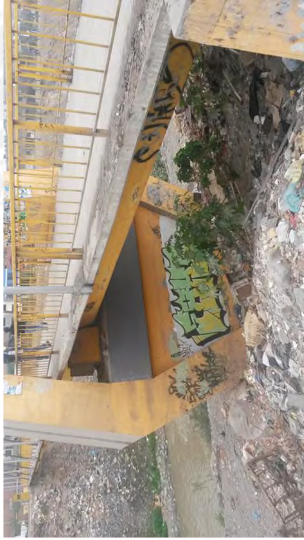
Foto 20 – Viga de las vigas diafragma a lo largo de la viga metálica
