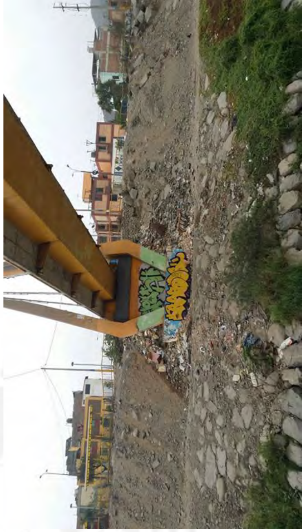
Foto 12 – Vista frontal de la viga metálica descansando sobre el apoyo intermedio
