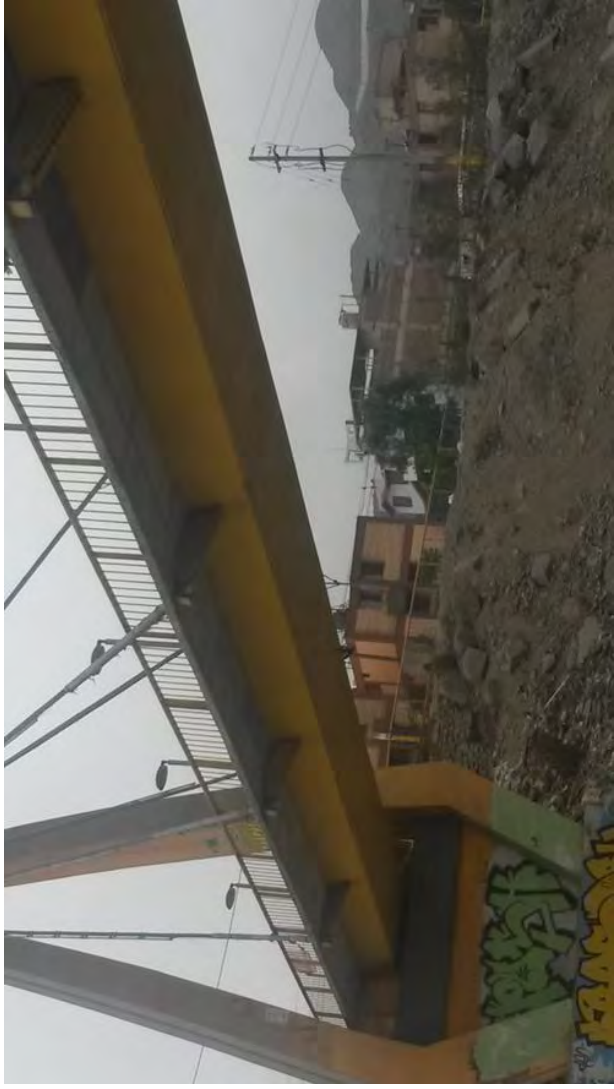
Foto 20 – Viga de las vigas diafragma a lo largo de la viga metálica
