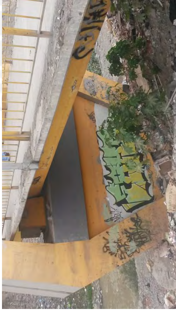
Foto 58 – Apoyo Intermedio (unión de los tramos)
