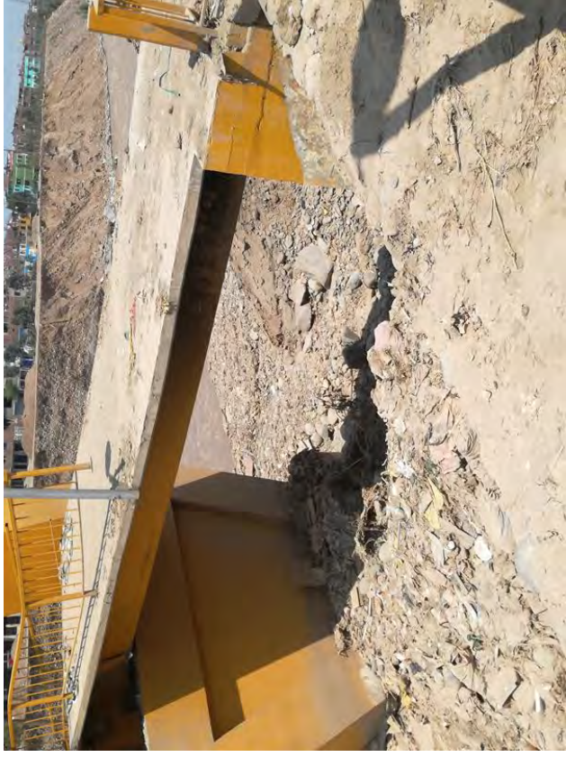
Foto 34 – Tramo de la viga de concreto armado
