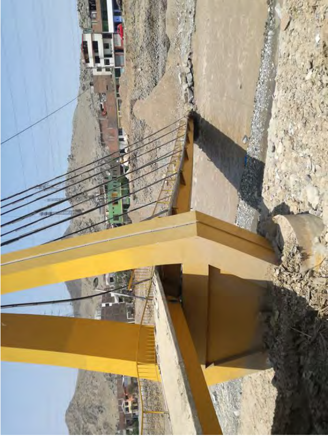
Foto 42 – Vista de la erosión del terreno donde se ubicaba el estribo izquierdo
