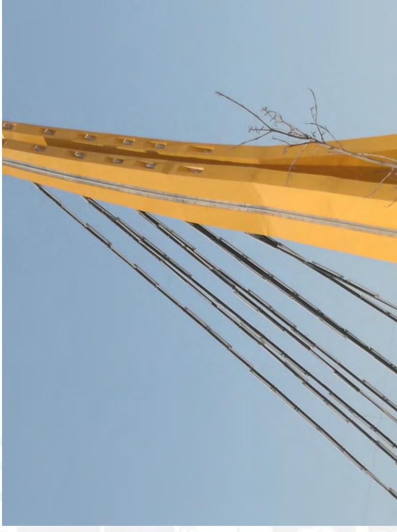
Foto 33 -- Anclaje de los cables en la cúspide de la torre
