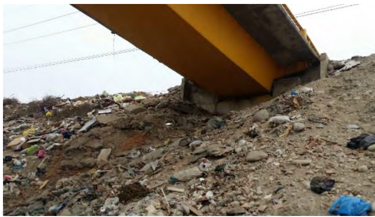
Suelo donde se apoya el estribo izquierdo – Figura 5.1
