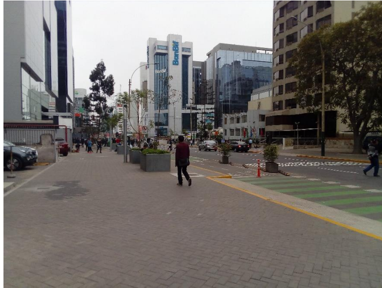
Ilustración 53: Av. Rivera Navarrete remodelada (estado actual 2017).
