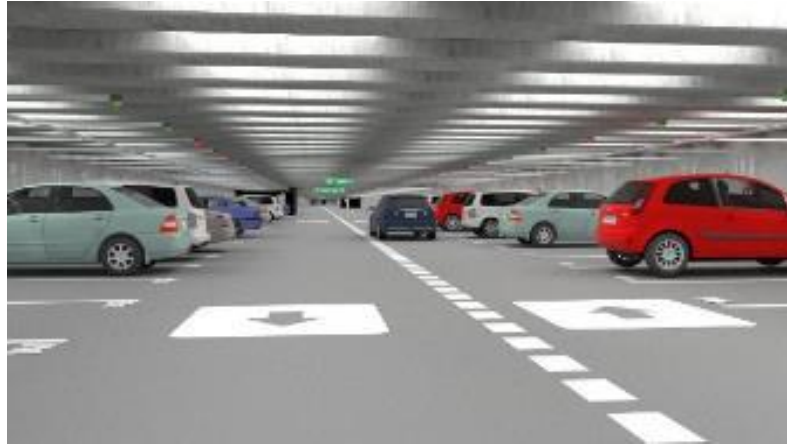
Ilustración 26: Modernos sistemas de vigas pretensadas sin uso de columnas.
