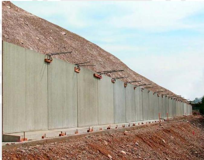
**Figura 69.-** Muros de contención reforzados con FRP
