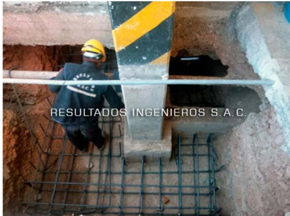
**Figura 69.-** Instalación de FRP en zapatas
