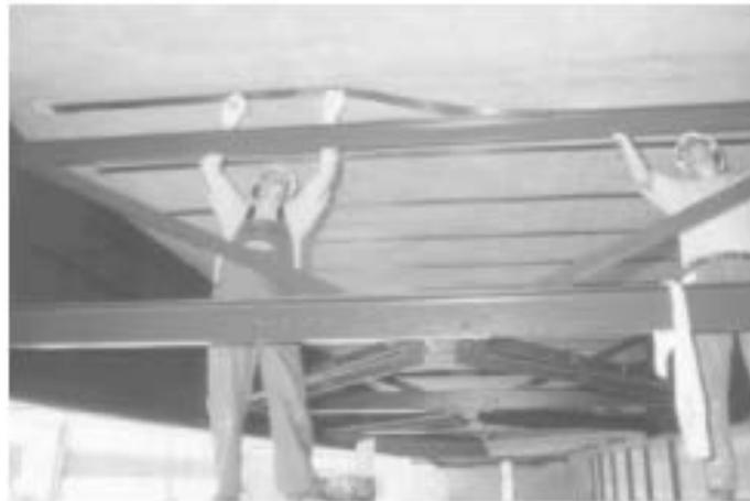
**Figura 67.-** Instalación de cintas prefabricadas de FRP a una losa de concreto
