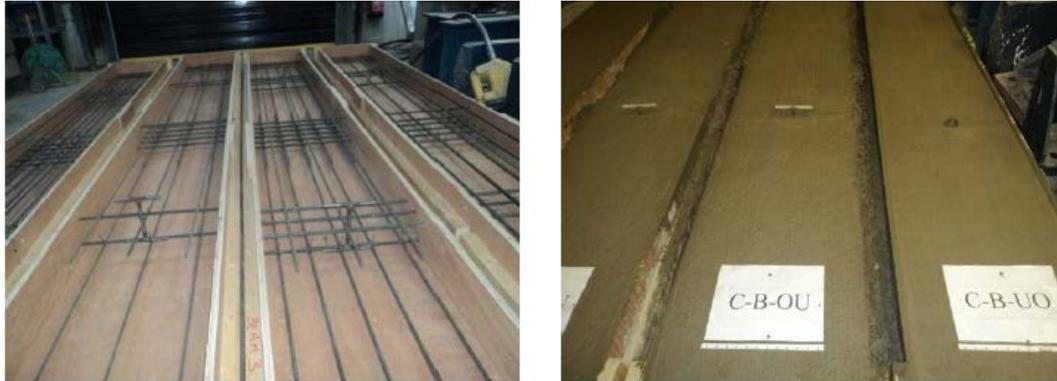
**Figura 28.-** Detalle del refuerzo y vaciado de vigas C-B-OU y C-B-UO.
