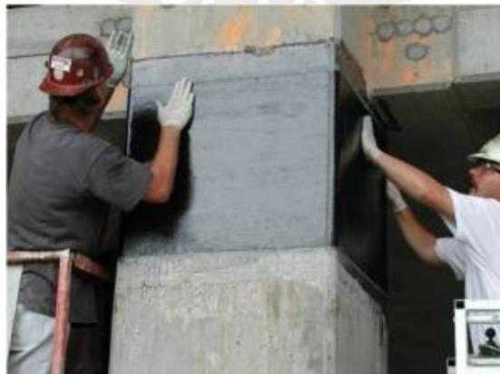
**Figura 48.-** Tableros reforzados con FRP en puentes isostático 48
