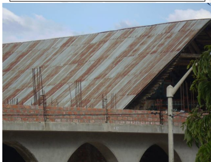
Vista externa del techo de la iglesia de Mangas
