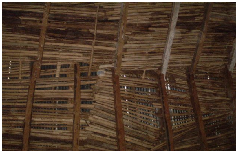
Vista Interna del techo de la Iglesia de Mangas
