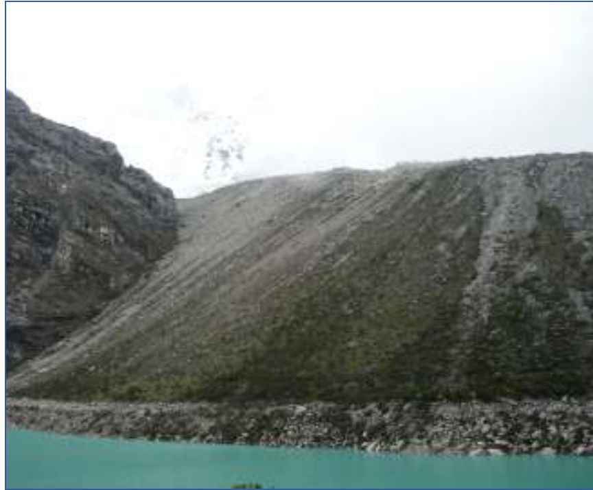
Figura 3.2.1: Arriba: Vista de la morrena que embalsa naturalmente a la laguna Parón. Abajo: Vista de la salida del túnel de descarga por donde es regulada la laguna Parón y vista del vertedero por donde se evacúa el agua proveniente de la laguna Parón hacia el río Parón. (Foto: Mónica Untiveros Lázaro. Fecha: Febrero del 2009)
