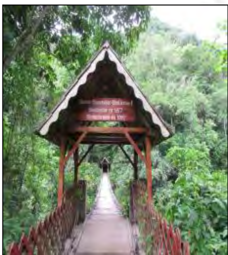
Imagen N° 4. Puente Guillermo I
