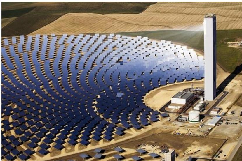
Figura 1. 9: Vista aérea de un proyecto termosolar compuesto por una torre solar y heliostatos [9].
