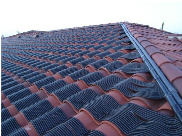
**Figura 1. 4: Colector solar plano sin cubierta flexible, montado sobre un techo de tejas de fibrocemento [4].**
