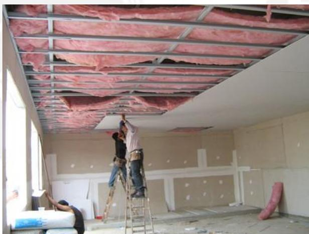
**Figura 1. 3: Obreros instalando un falso techo de drywall<sup>4</sup> aislado con lana de vidrio, el verdadero techo no es visible [3]**
