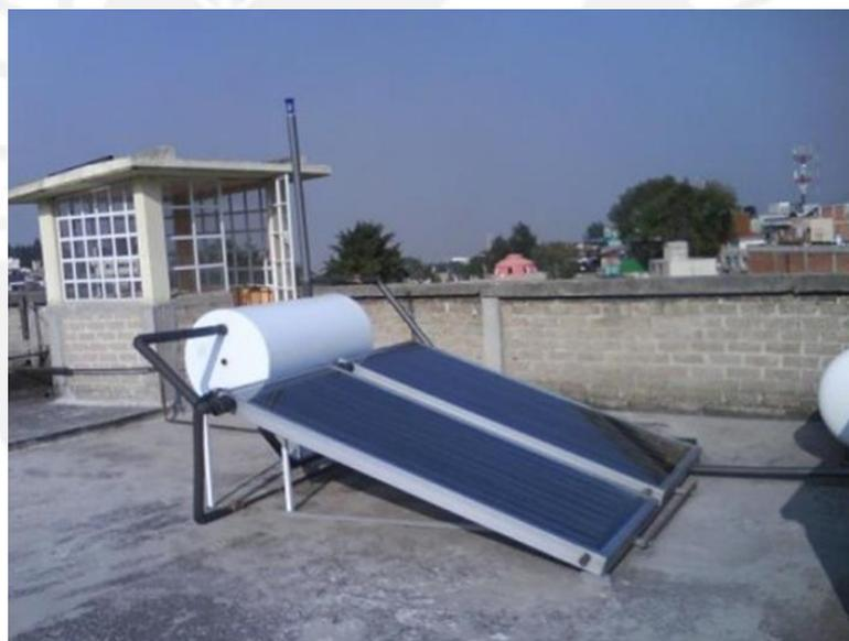
Figura 1. 7: Instalación de una batería de dos colectores planos con cubierta, con un tanque almacenador, sobre un techo [7].
