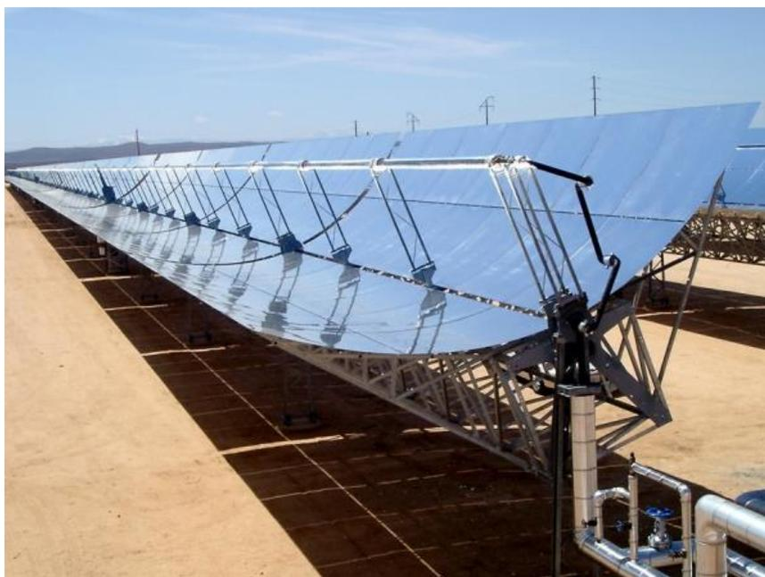
**Figura 1. 8: Montaje de un colector solar de tubo al vacío con colector parabólica con seguidor solar [8].**
