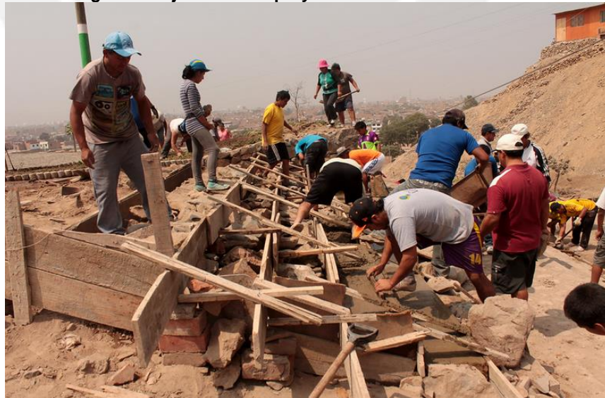
Figura 15. Ejecución del proyecto con mano de obra local
