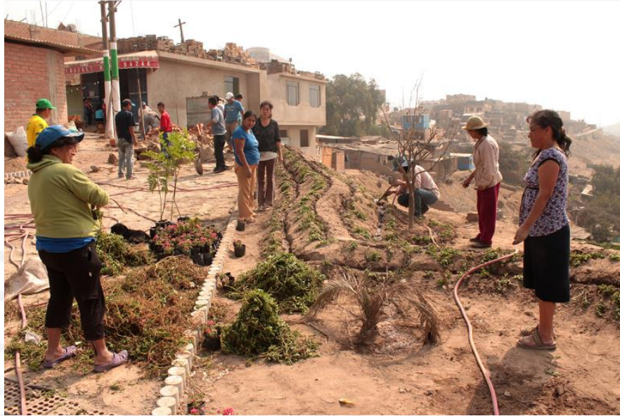
Figura 14. Ejecución del proyecto con ayuda de los vecinos
