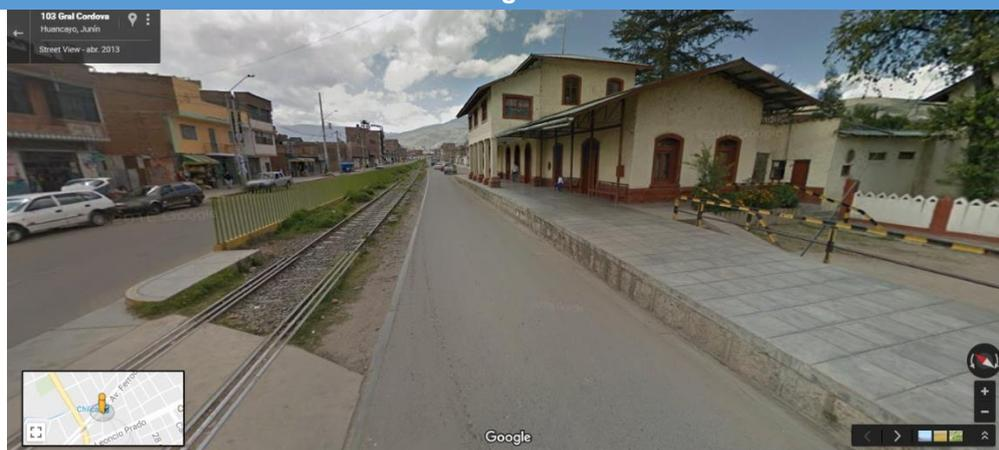
Las vías se encuentran en estado de desuso y abandono. Se hace evidente la necesidad de la rehabilitación de la superestructura (rieles, durmientes y balasto) y limpieza de las vías.
