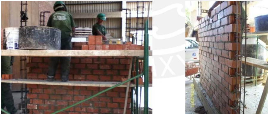
Figura 6.2 Asentado de ladrillos y unión albañilería-columna
