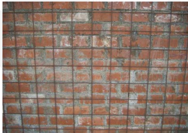
Figura 6.4 Malla electrosoldada en el muro M2
