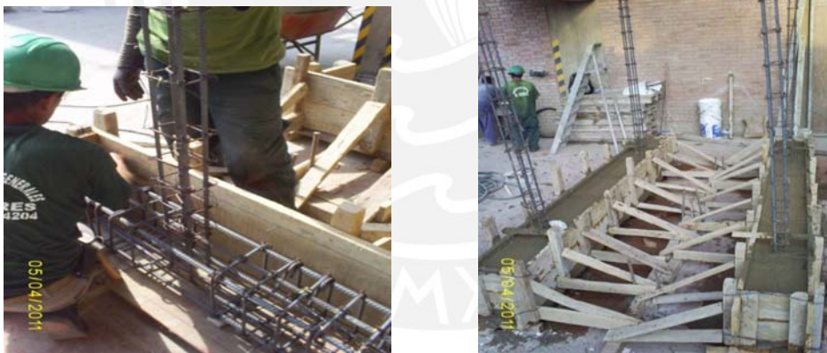
Figura 6.1 Encofrado y vaciado de la Viga de Cimentación
