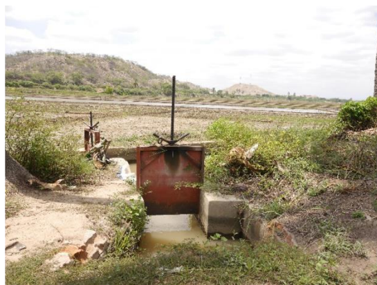
7. Compuertas metálicas - Bloque San Francisco. (17/02/2016)
