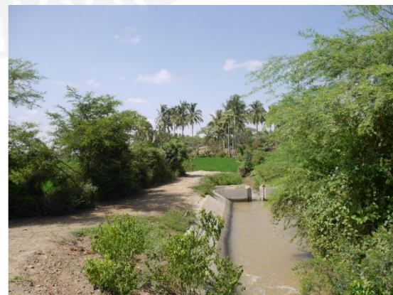
17. Canal lateral - Bloque Samán. (1/03/2016)
