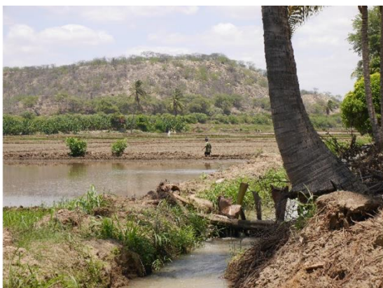
6. Compuerta rústica - Bloque San Francisco. (17/02/2016)
