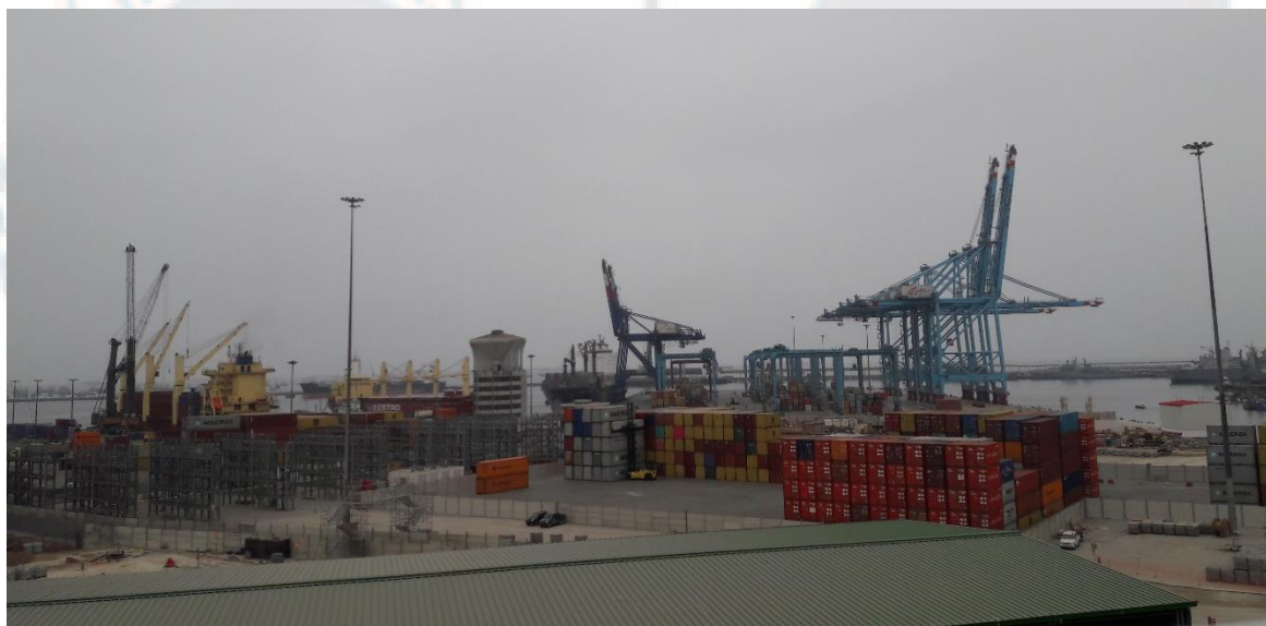
Figura 3. Vista de las grúas Post Panamax del Terminal Norte Multipropósito operado por APM Terminals Callao
