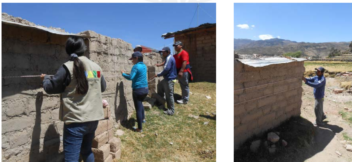
Figura 4.23. Colocación de cuerdas horizontales.
