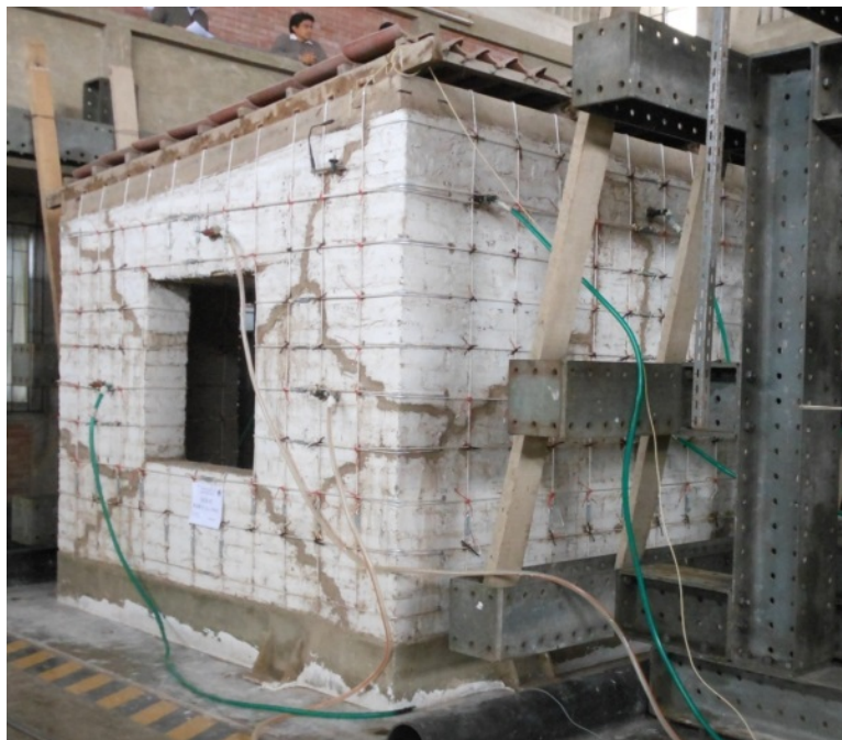
Figura 2.2. Modelo reparado con inyecciones de barro y reforzado con malla de cuerdas (Blondet et al. 2013).
