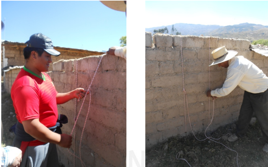
Figura 4.24. Colocación de cuerdas verticales.
