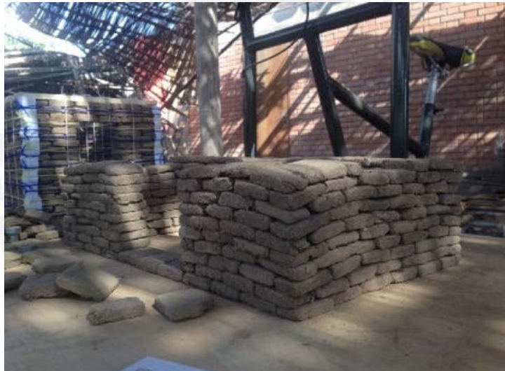
Figura 3.4. Unidades apiladas y traslapadas sin mortero de barro.
