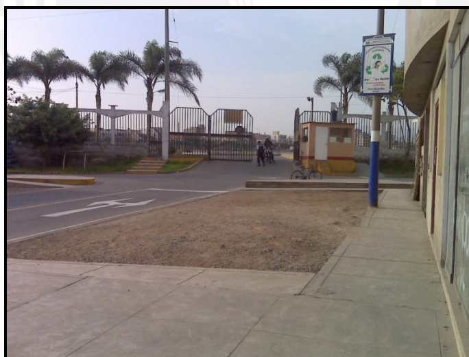
Fotografía 16 Reja perimétrica hacia la explanada del Estadio Monumental
