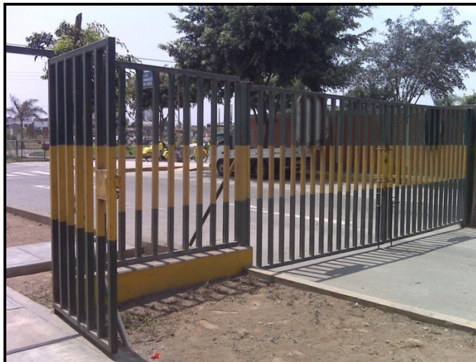
Fotografía 8 Bucaramanga: reja abierta a peatón y cerrada para vehículos (La Molina)
