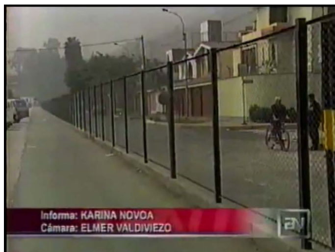
Malla metálica instalada en el 2005 por iniciativa de vecinos de La Molina en el límite con Ate (calle Bucaramanga).
