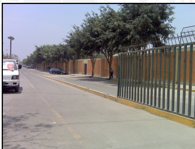
Fotografía 4 Calle Bucaramanga: sardinel y reja a medio instalar
