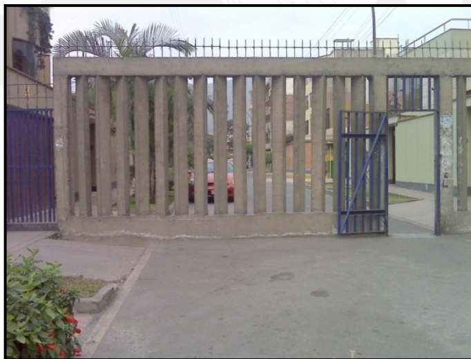
Fotografía 1 Muro de concreto en calle Barcelona (urbanización Mayorazgo, Ate)
