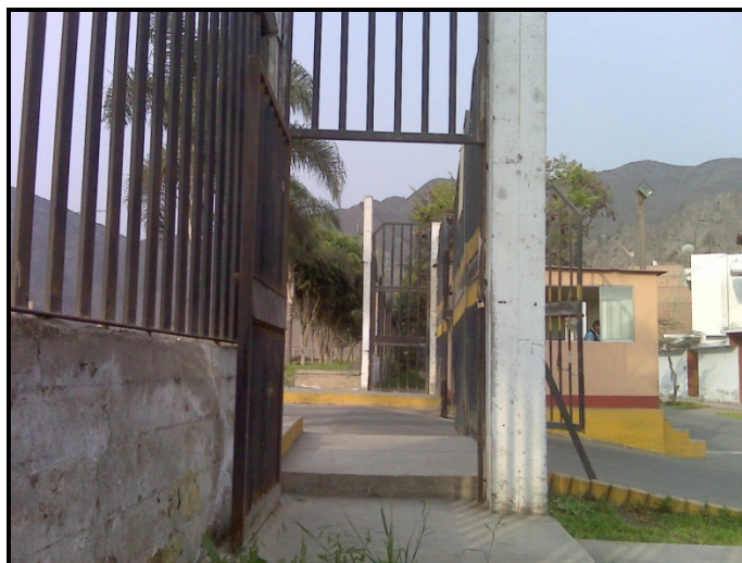
Fotografía 17 Puerta para peatones con salida hacia la explanada
