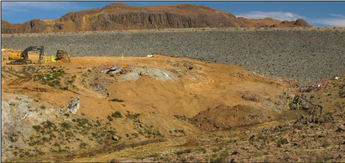
Figura Nro 05: Presa de Relaves UO Arcata
