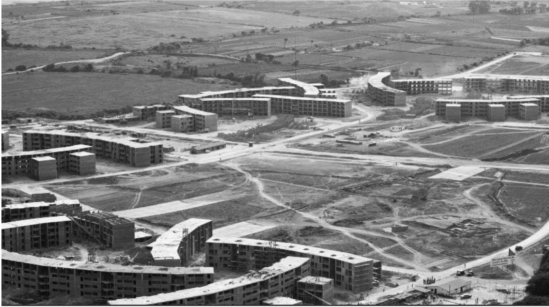
Figura 3. Construcción del Conjunto Habitacional Palomino. Devenir (Carcedo de Mufarech y Advíncula 2015: 104). Original: DIRAF - FAP (1965)
