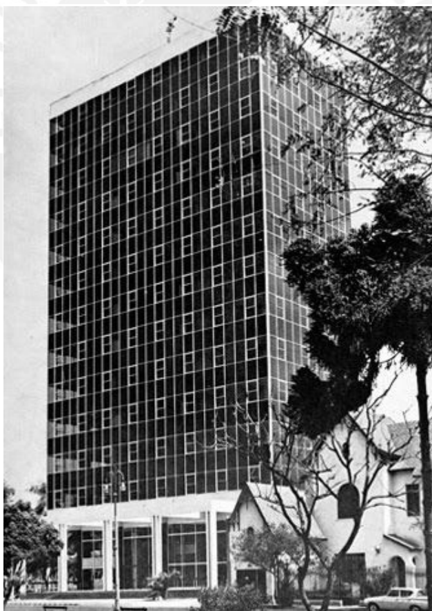
Fig 4. Edificio El Pacífico Washington (Gubbins 1964: 40) Foto tomada desde el frente de la calle Natalio Sánchez, se observa su emplazamiento continuo a arquitectura pintoresquista, la casa colindantes se ha demolido.
