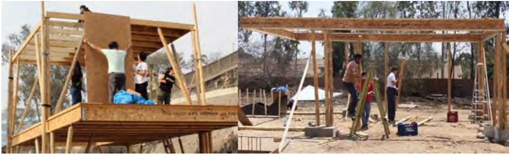
Figura 3. 11. Montaje de la estructura de la vivienda
