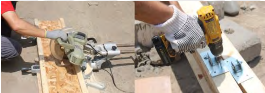
Figura 3. 8. Corte de las vigas I-Joist con dimensiones requeridas e inserción de platinas metálicas ejecutadas por el IVUC.
