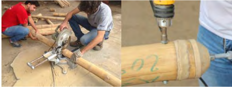
Figura 3. 9. Corte de las vigas bambú con dimensiones requeridas e inserción de las uniones en los extremos Fuente: IVUC, 2020.
