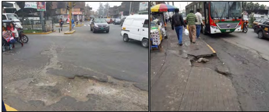
Figura 32 Ingreso en la Av. José Carlos Mariátegui
