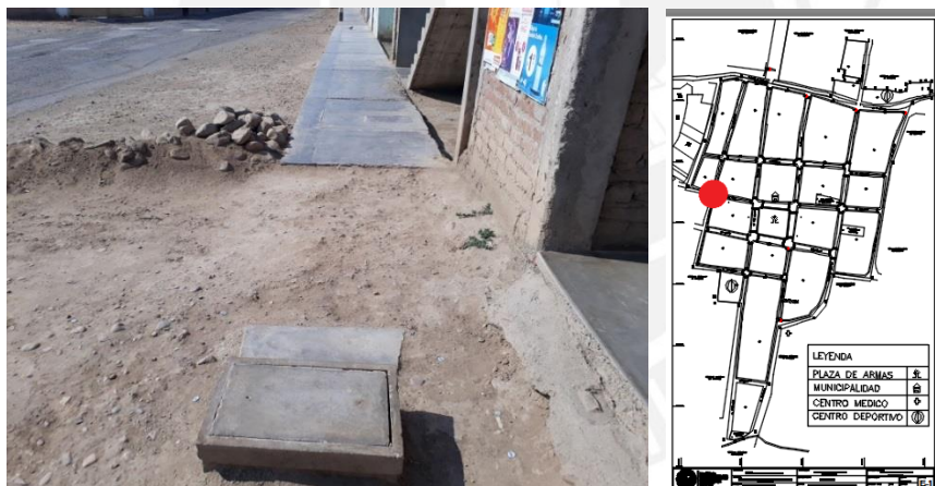
Figura 3.6: Cruce de las Calles San Jose y Pacasmayo, donde no hay continuidad de veredas a lo largo de la calle San José.
