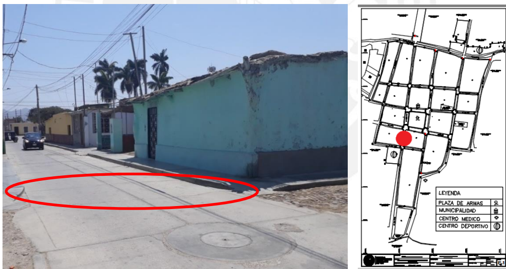
Figura 3.19: Esquina de la calle San Pedro con San Pablo sin señalización de cruce peatonal
