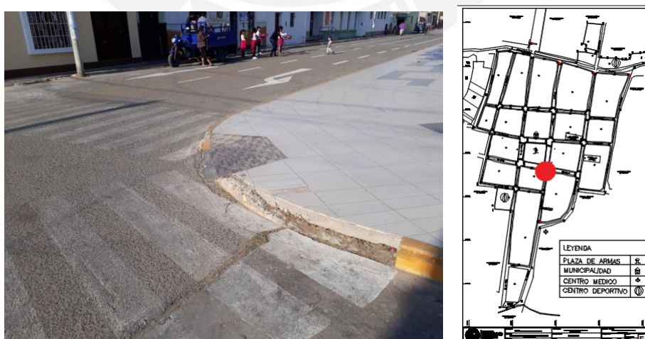
Figura 3.15: Rampa para personas con movilidad limitada ubicada en la esquina a la entrada a la Plaza de Armas.
