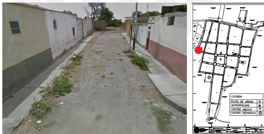
Figura 3.24: Tercer tramo de la calle San José, a dos cuadras de la plaza de armas, empedrado, no hay señalización y presencia de vegetación, ancho de calle de 4m.
