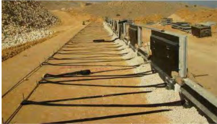
*Figura 10. 5 Colocación de primera fila de paneles prefabricados. Fuente: (Freyssinet Tierra Armada, 2015)*
