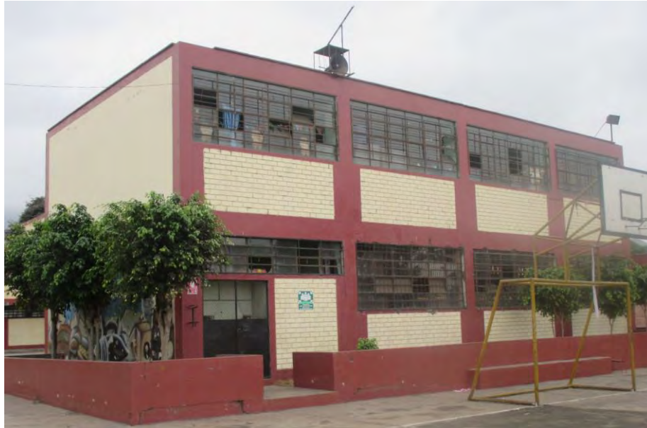
Figura 4. Fotografía fachada posterior módulo INFES existente
